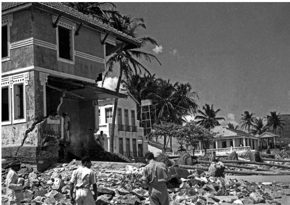
Figura 03. Edificações na orla da Praia de Iracema destruídas em decorrência do avanço das marés, após a transferência do porto para a Praia do Mucuripe.
