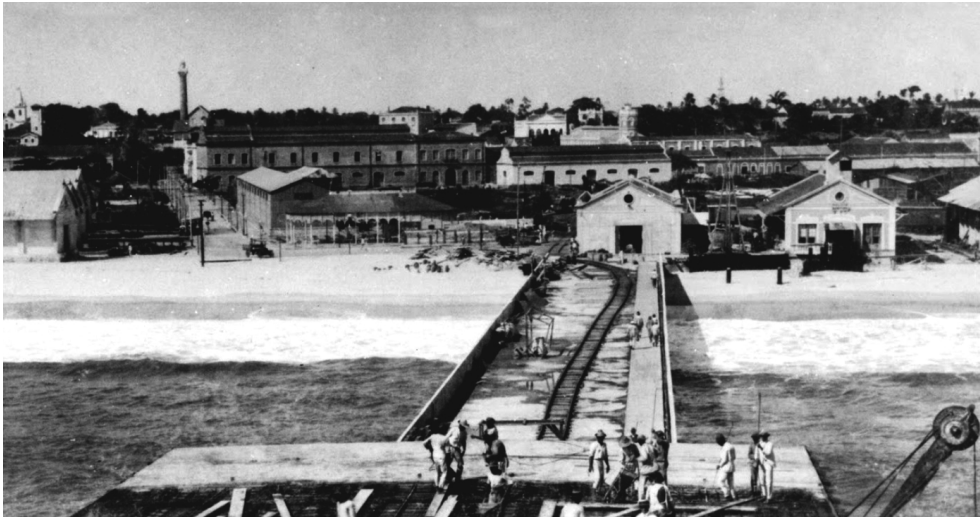
Figura 01. Reconstrução da Ponte Metálica em concreto.
