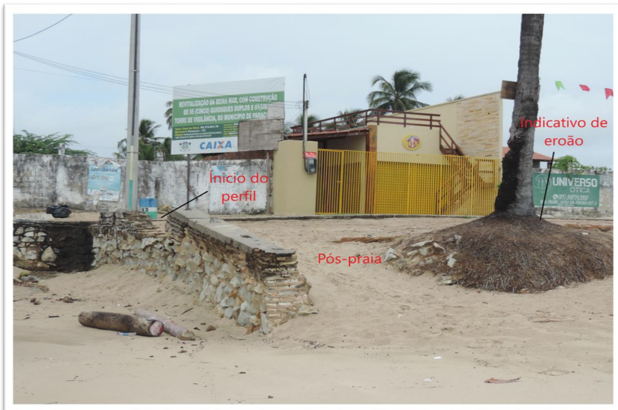
Figura 26: Indicativo de erosão no ponto de monitoramento 02
