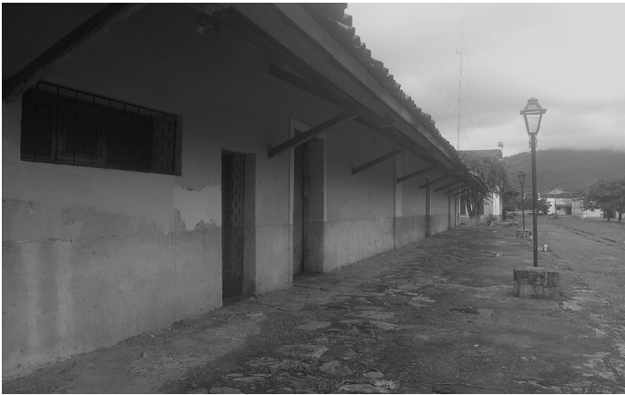
Foto da fachada norte. Fonte: produzido pela autora.
