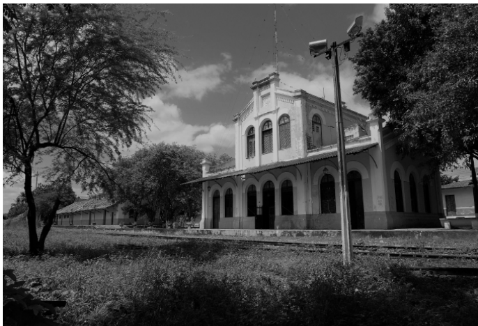
Foto da fachada norte. Fonte: Ramiro Teles Beserra.
