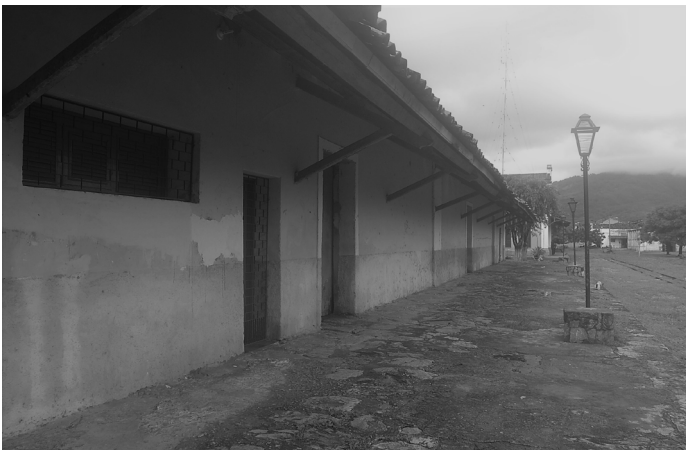
Foto da fachada norte. Fonte: produzido pela autora.
