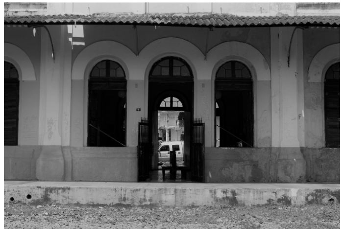
13. Foto da fachada norte. Fonte: Ramiro Teles Beserra..
