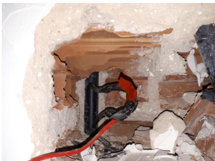
Figura 7 – Derivação no Ramal de Entrada
