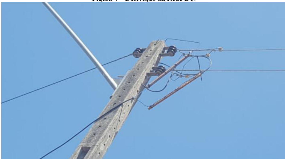
Figura 4 – Derivação na Rede BT.
