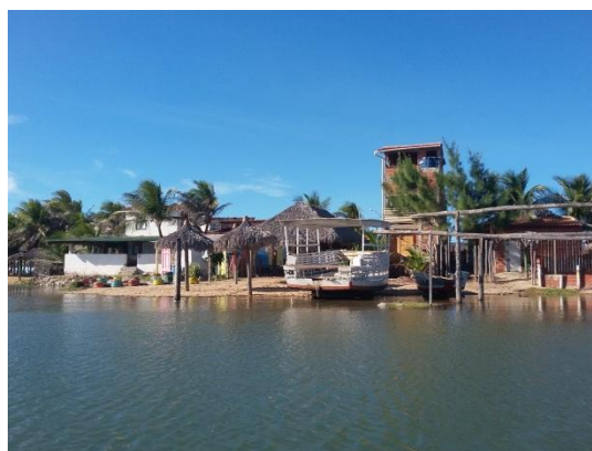
Figura 30. Edificações nas margens do rio Cocó. Datado de 22/06/2017.
