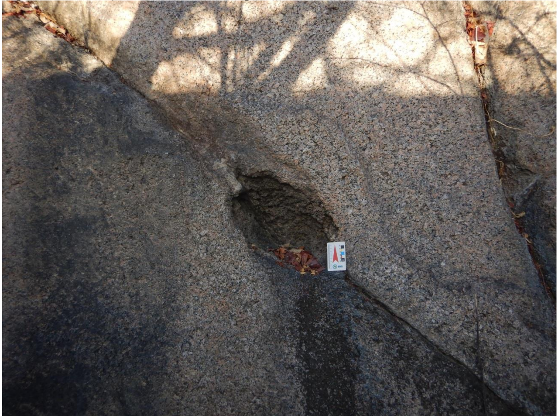
Figura 32 – Honeycomb condicionado por fraturamento na massa rochosa.
