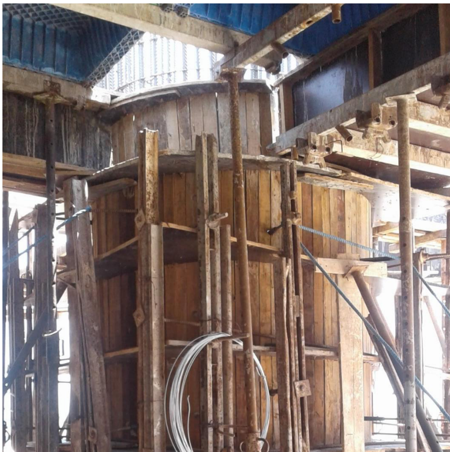
Figura 17 – Fôrma de madeira para pilar circular
