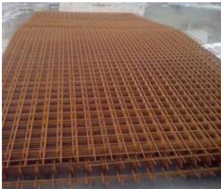
Figura 11 – Telas de aço soldadas para lajes
