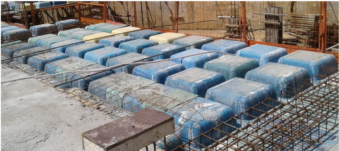
Figura 15 – Disposição de fôrma (cubetas) de laje nervurada
