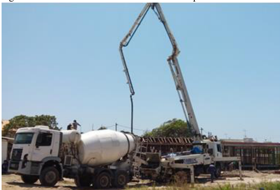
Figura 10 – Bombeamento de concreto usinado por meio de caminhão betoneira
