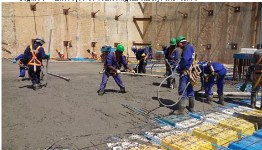
Figura 9 – Execução de concretagem em laje nervurada
