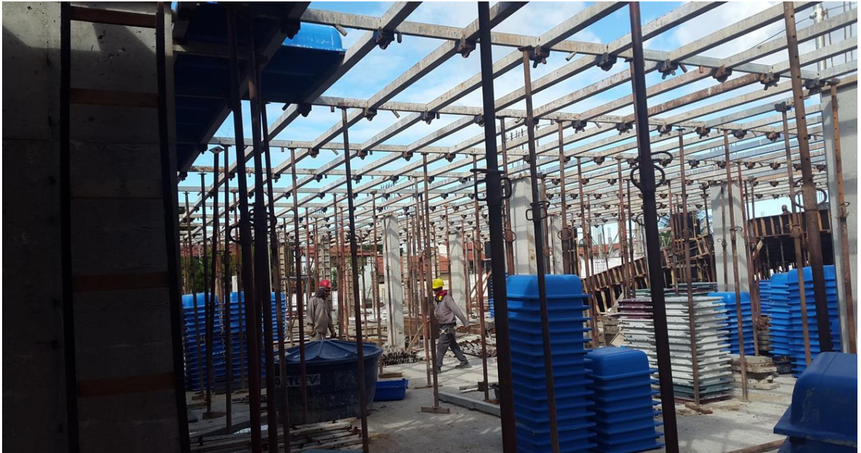
Figura 16 – Disposição de cimbramento metálico
