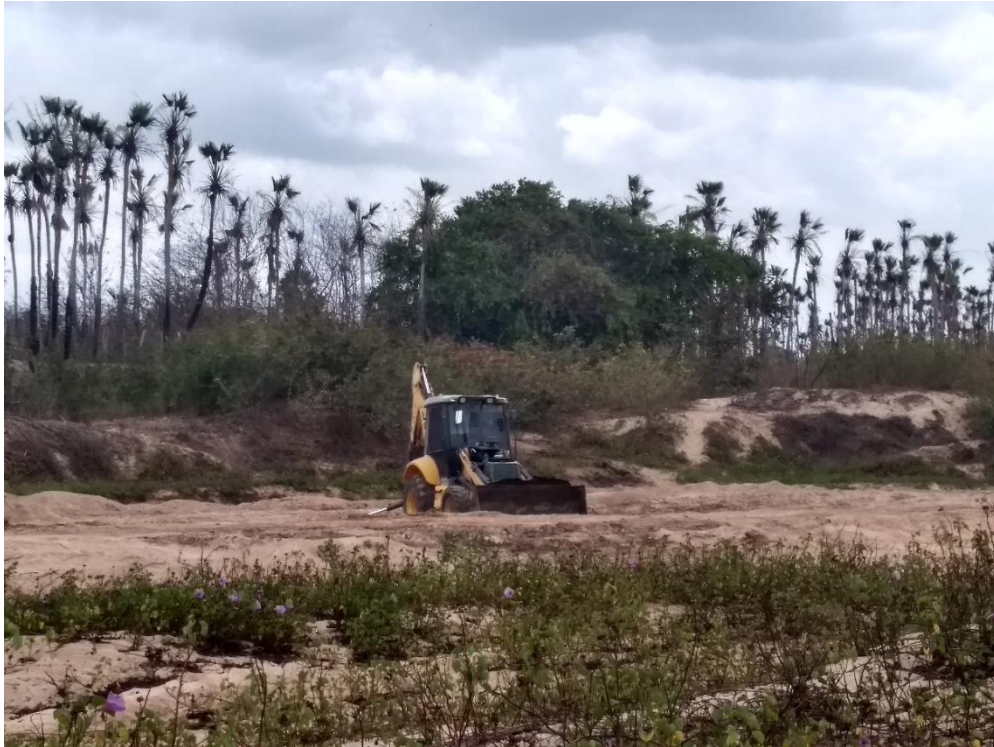
Figura 19 – Escavadeira retirando areia do leito do Rio Aracatiaçu no período seco
