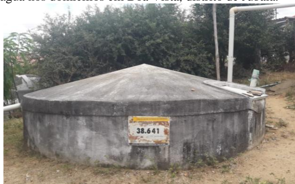
Fotografias 42 e 43 – Cisternas para armazenamento de água nos domicílios em Boa Vista, distrito de Jubaia.
