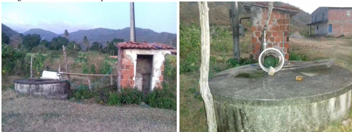
Fotografias 1 e 2 – Cacimbão que abastece a localidade de Pé de Serra no distrito de Jubaia.
