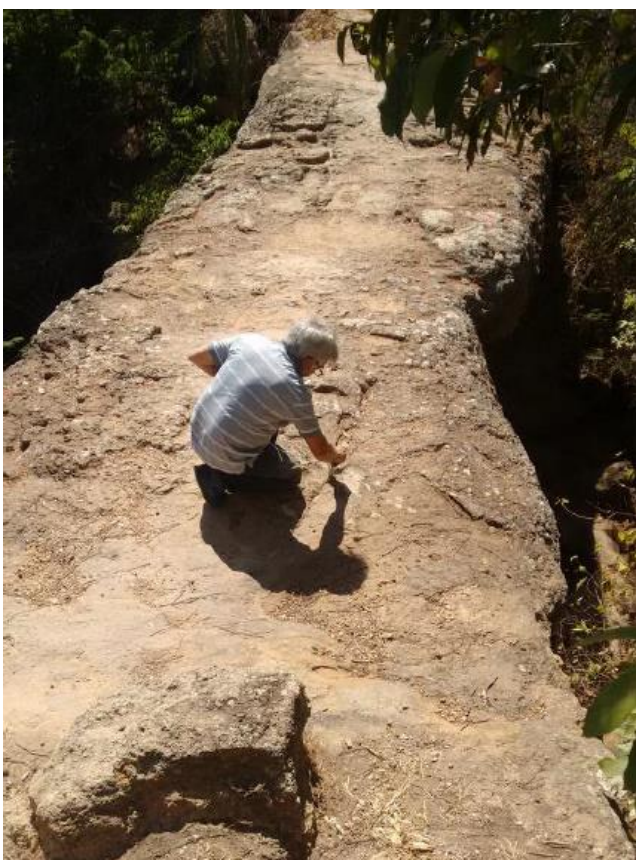
II - Processo de aplicação de gesso na fenda já limpa.
