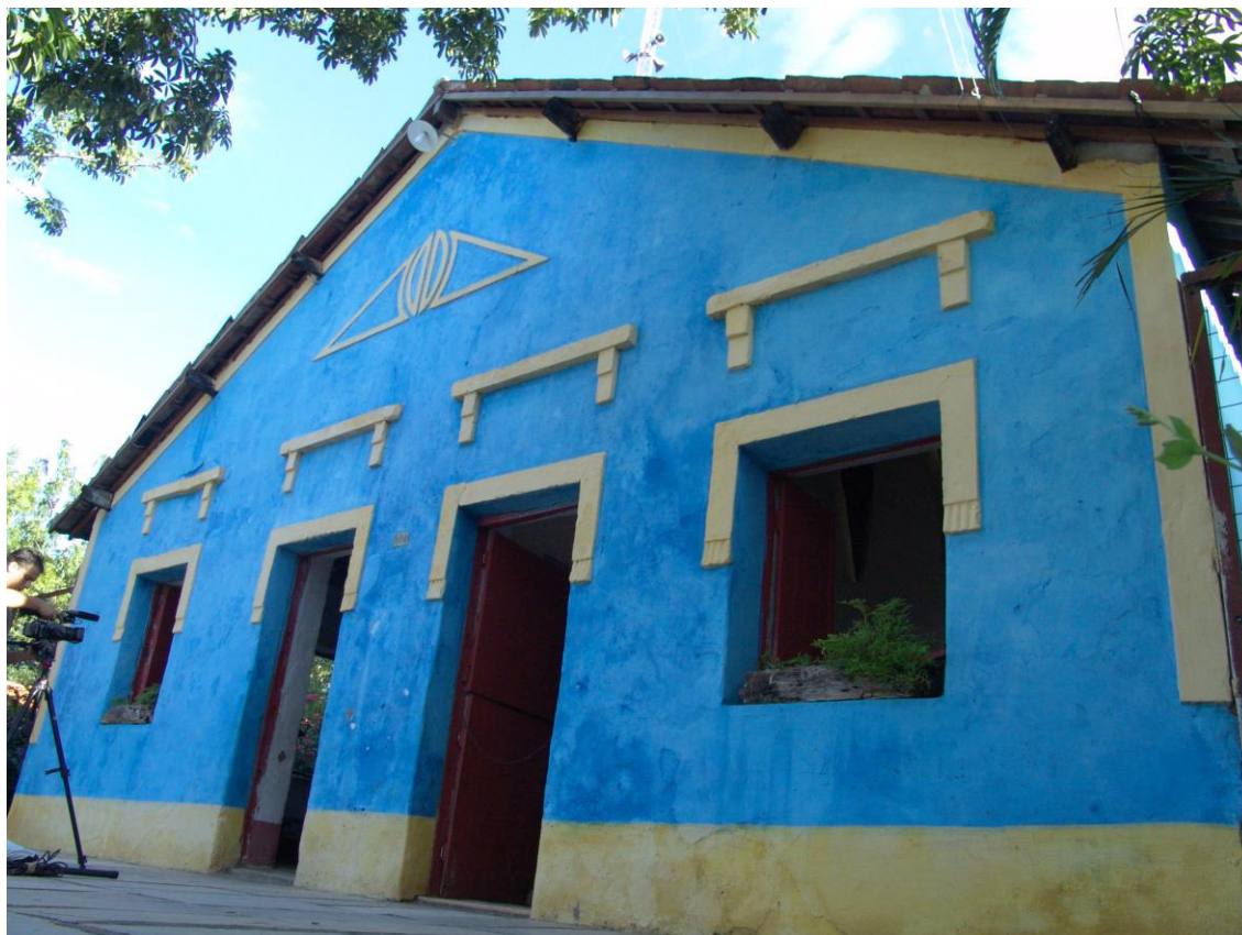
Figura 18 – Fundação Casa Grande de Nova Olinda – CE
