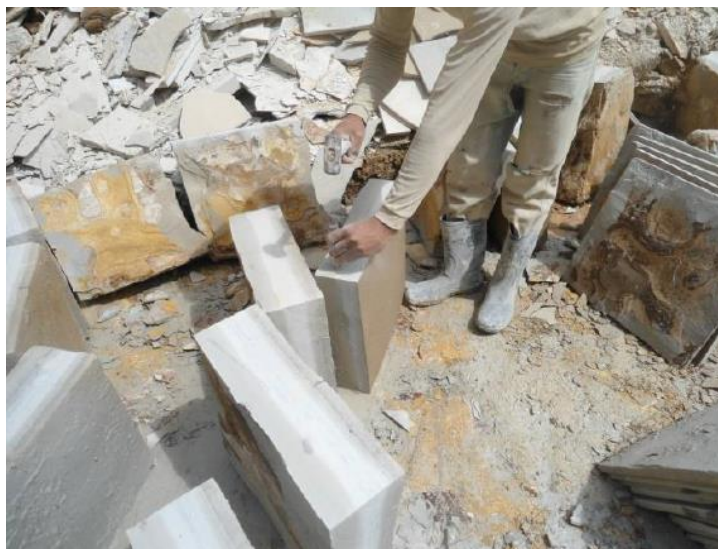
Figura 8 - Aspecto do deslocamento manual das lajotas
