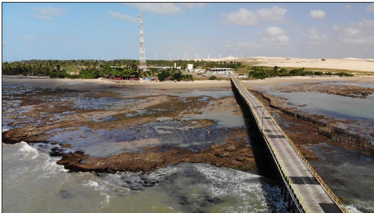
Figura 2: Praia da Pedra Rachada, Paracuru/CE.
