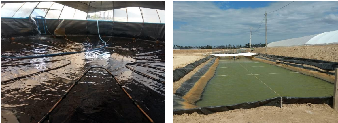
Figura 11 - Berçário intensivo e tanques de recirculação
