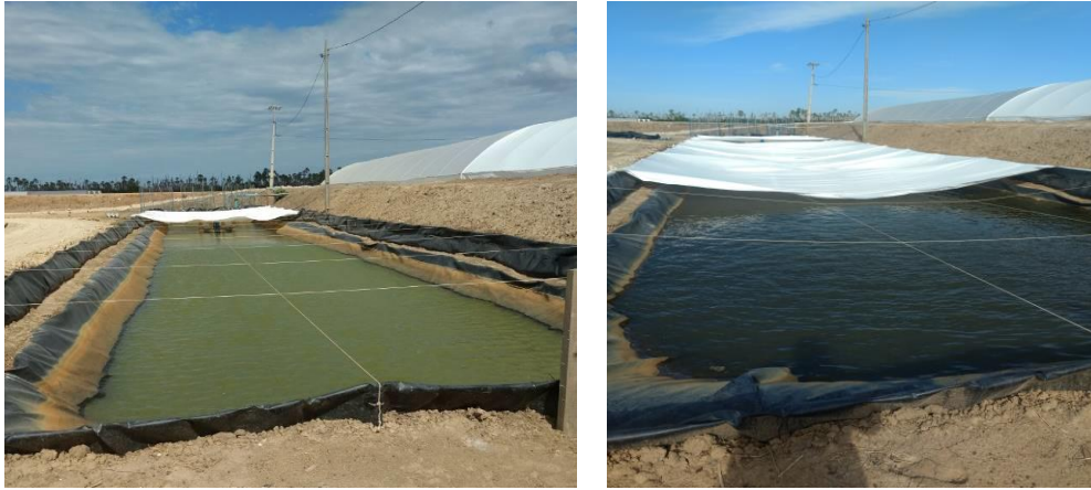
Figura 12 – Tanque de recirculação
