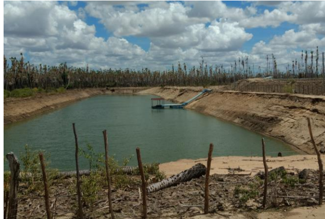
Figura 10 – Bacia de decantação.
