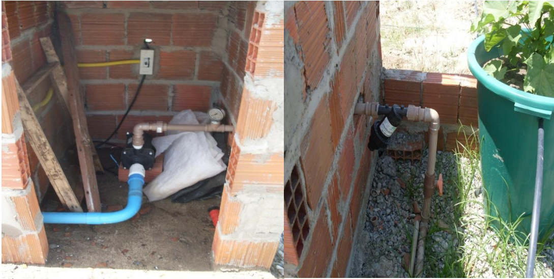
Figura 8. Cabeçal de controle utilizado para irrigação do experimento.
