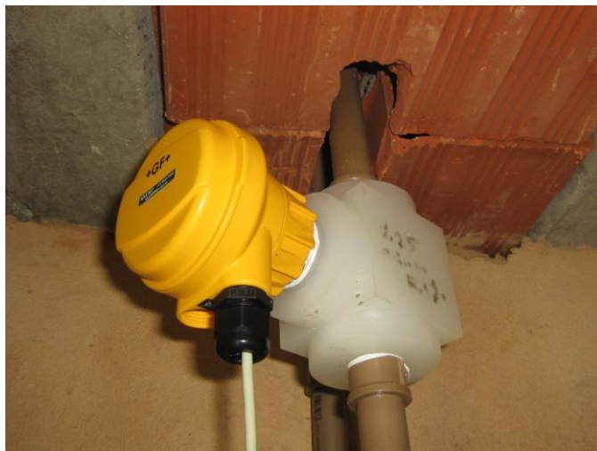
Figura 4.13 - Sensor de vazão.
