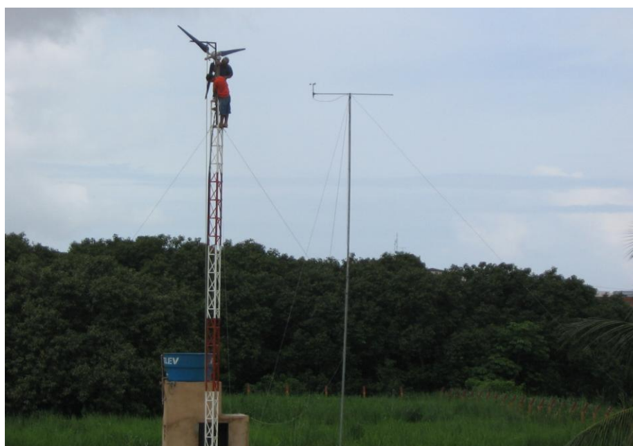
Figura 4.12 – Torre de sustentação do gerador eólico.
