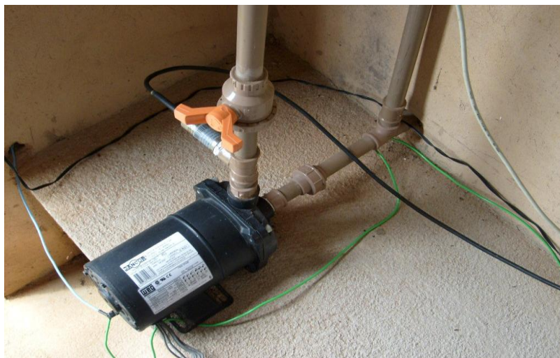
Figura 4.1 - Conjunto motor-bomba.
