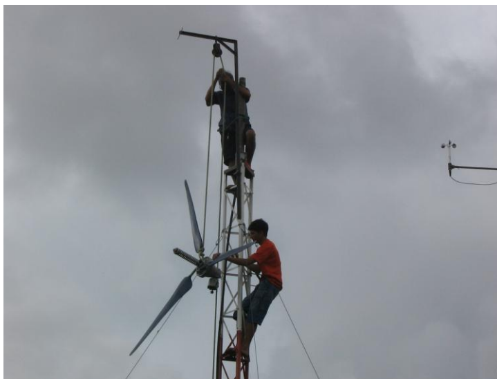
Figura 4.11 – Sistema de roldana para erguer o gerador ao topo da torre.
