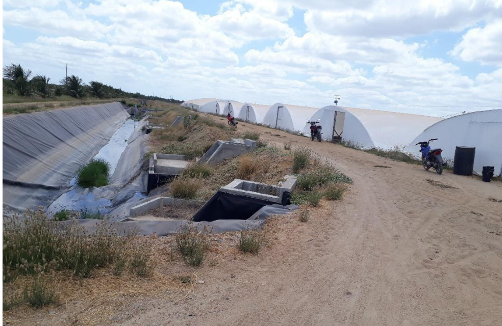
Figura 34 - Vista do canal de drenagem de todos os raceways .
