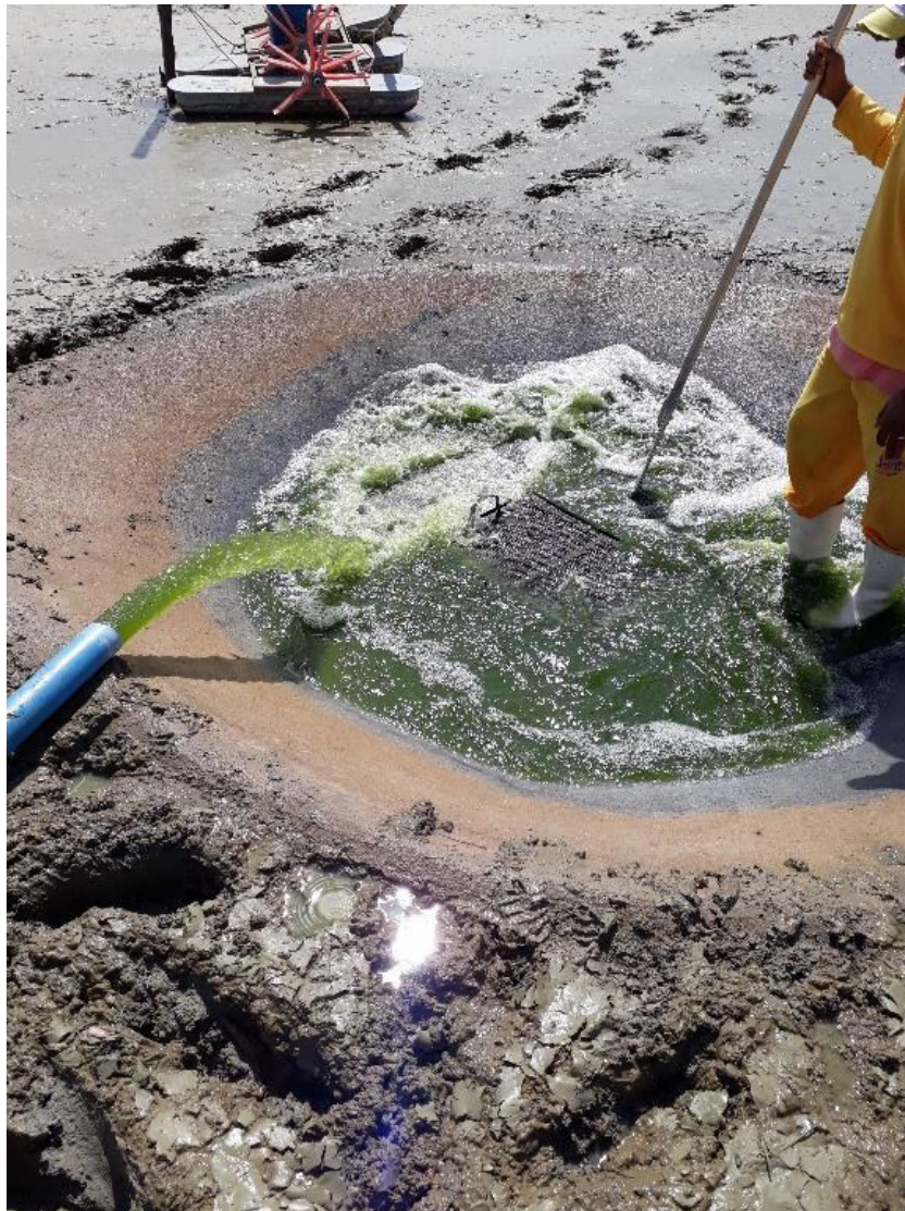
Figura 37 - Lavagem do dreno central.
