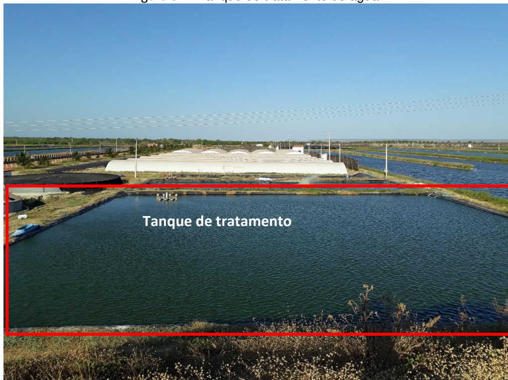
Figura 31 - Tanque de tratamento de água.
