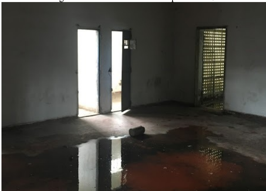
Figura 12 – Ala de solitárias do pavilhão 10.
