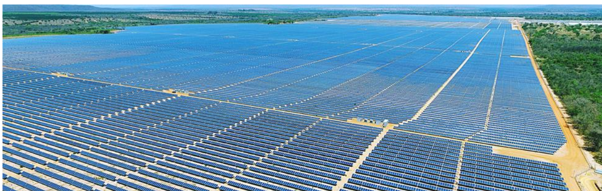
Figura 6 - Usina solar fotovoltaica de Pirapora-MG
