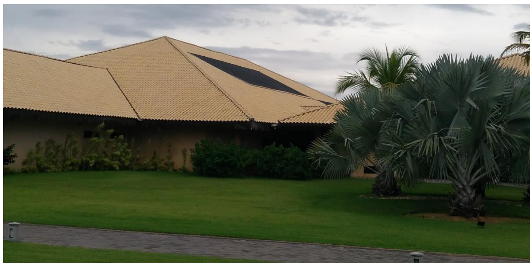
Figura 19 – Placa Solar instalada no telhado do spa.
