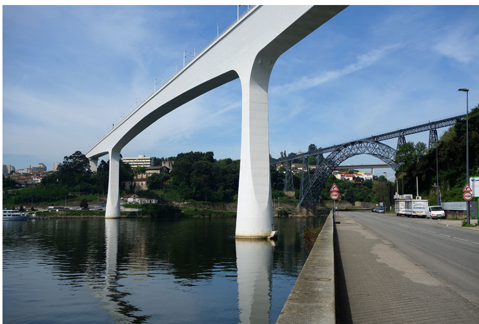
Figura 11 – Ponte de São João, em pórtico
