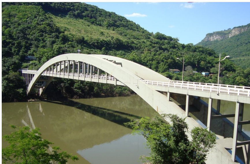
Figura 8 – Ponte em arco Ernesto Dornelles
