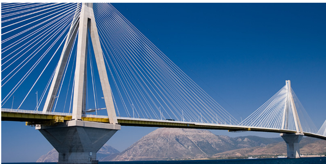
Figura 10 – Ponte estaiada com seus cabos dispostos em formato de leque
