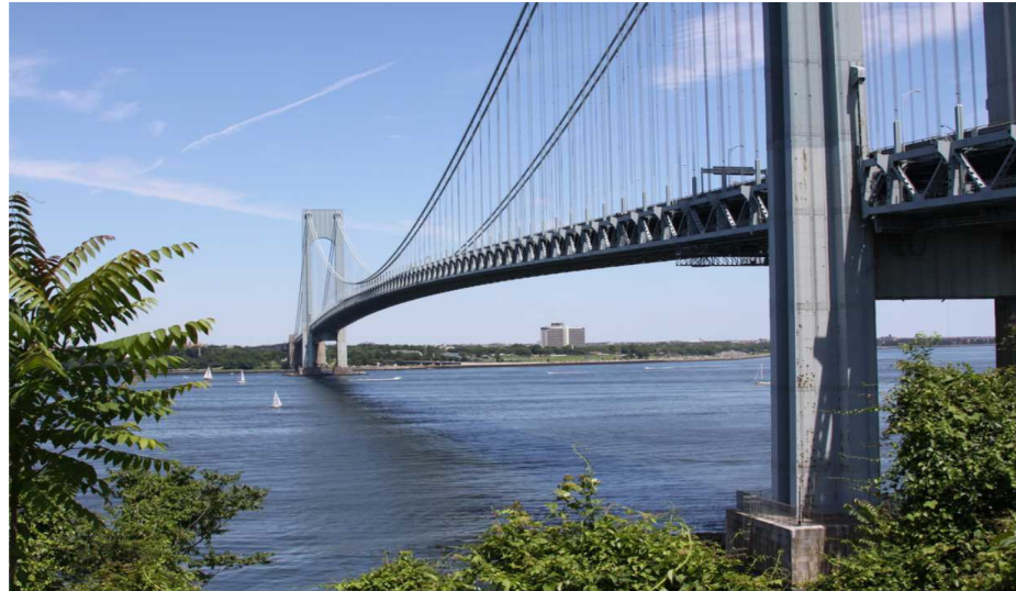
Figura 9 – Ponte pênsil Verrazano-Narrows
