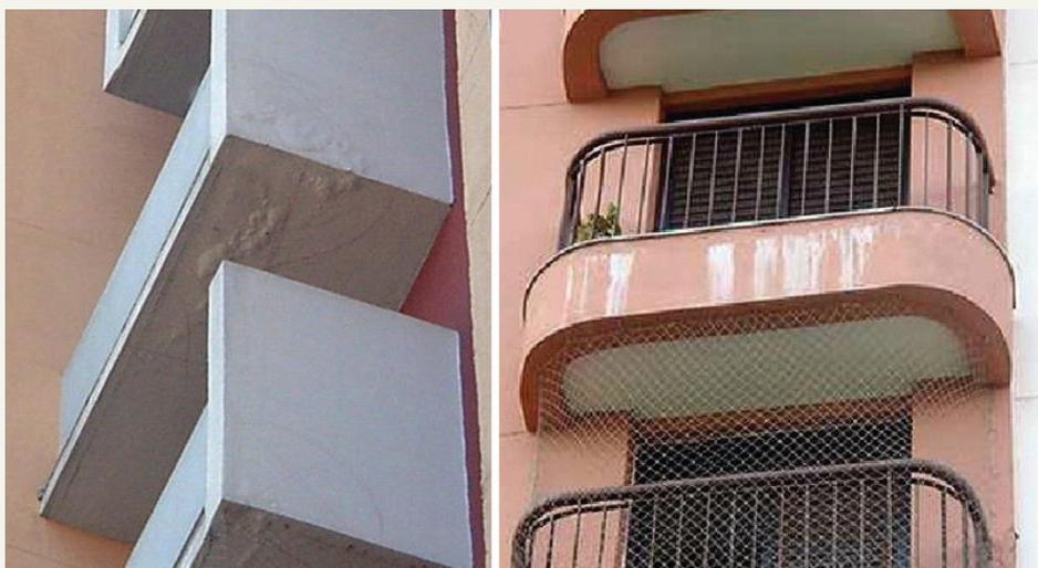
Figura 27 - Patologias em terraços por infiltrações de água em pisos sem impermeabilização.
