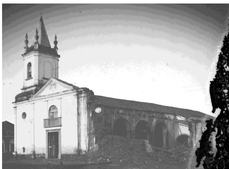
Figura 7 – Registro Fotográfico do colapso parcial da igreja em 1924
