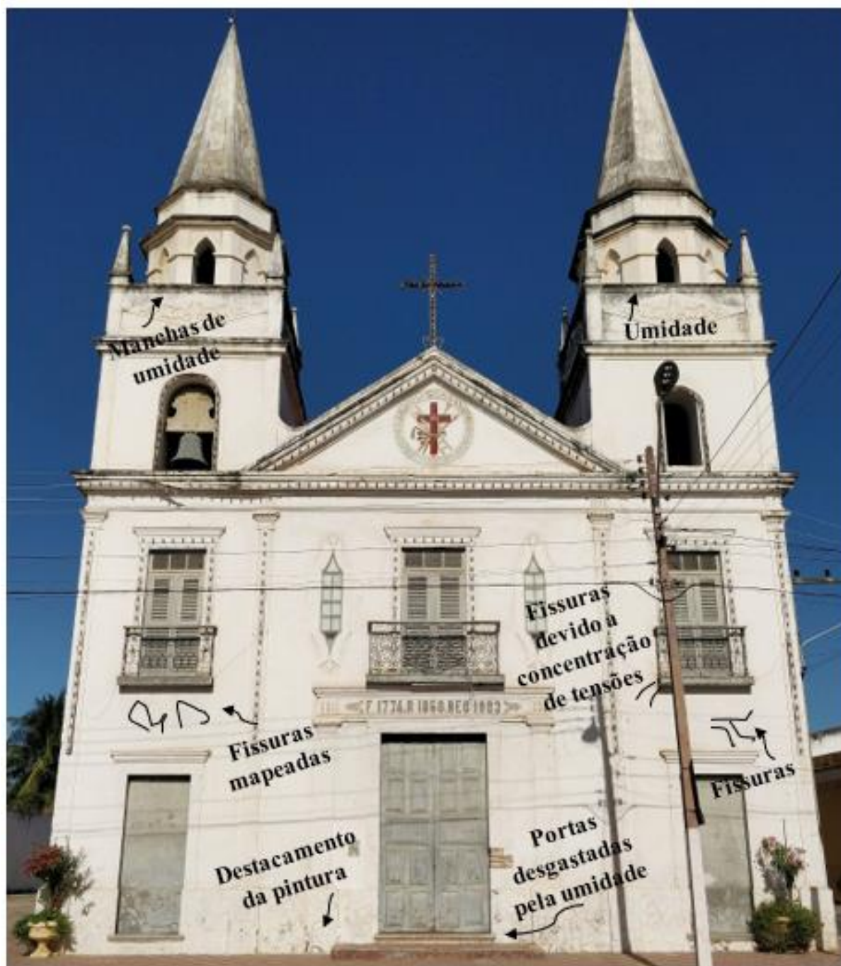
Figura A.1 – Mapeamento de danos da fachada da Igreja de Nosso Senhor do Bonfim.
