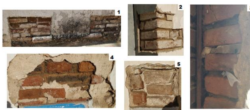
Figura 6 – Tijolos maciços argamassados em paredes com alvenaria exposta.
