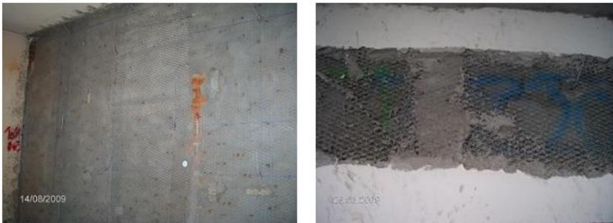
Figura 28 – Exemplo de um reboco armado com rede metálica.
