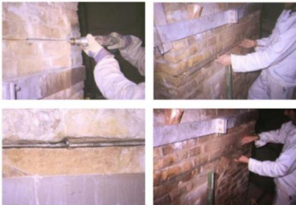
Figura 20 – Procedimentos em um refechamento armado com reforço de armaduras.
