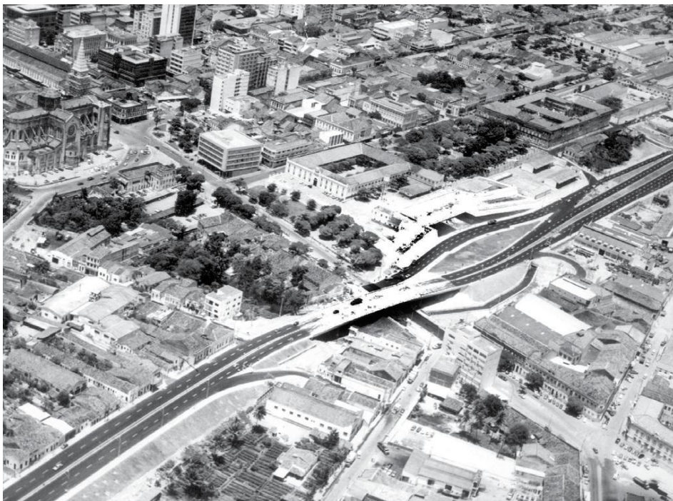
Figura 3.3 - Avenida e viaduto Leste-Oeste em Fortaleza, 1974, com o Forte Nossa Senhora da Assunção no centro da fotografia e a Catedral de Fortaleza no canto superior esquerdo. Nota-se como a construção do viaduto alterou a percepção dos edifícios históricos, mudando a relação entre espaços livres e os edifícios.
