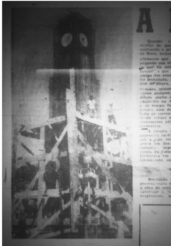
Figura 3.28 - Demolição da Coluna da Hora noticiada pelo jornal O Povo.
