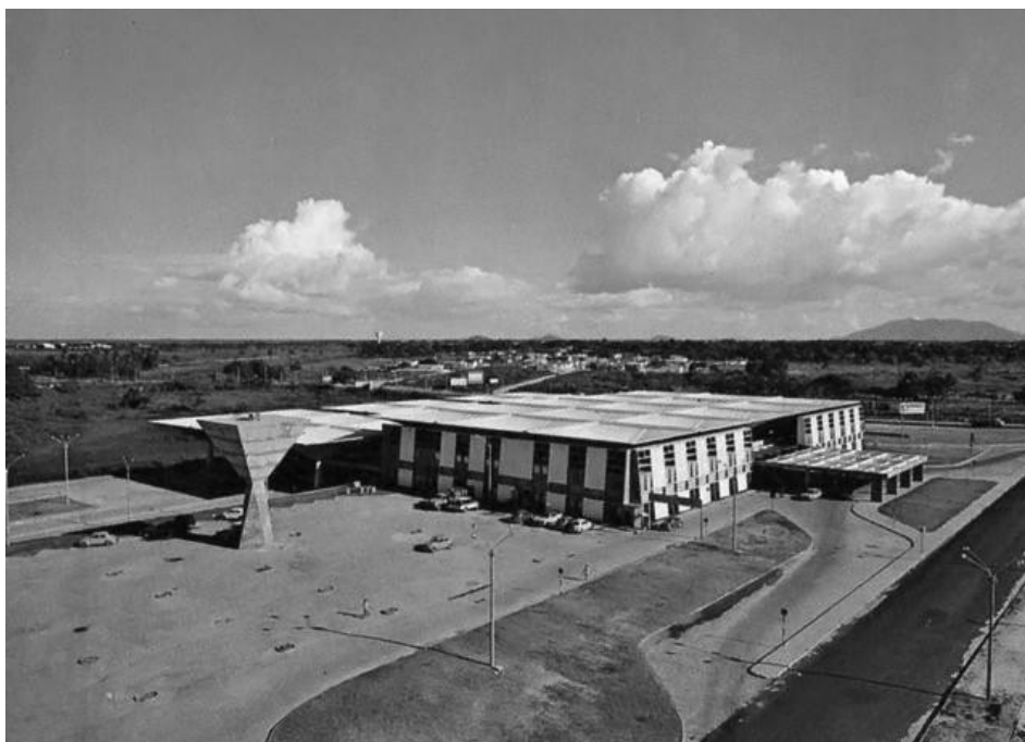
Figura 4.22 - Terminal Rodoviário Engenheiro João Tomé, Fortaleza. Percebe-se que ainda não havia uma grande quantidade de edificações no entorno do local.
