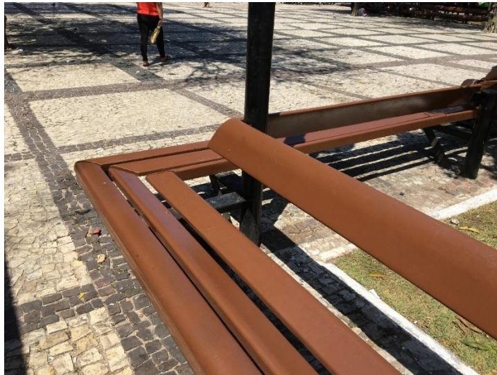
Figura 4.59 - Banco da Praça do Ferreira. Observa-se a sua conexão à estrutura do poste de iluminação.
