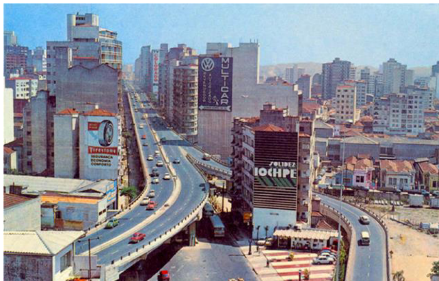
Figura 3.1 - Viaduto Presidente João Goulart, antigo Elevado Costa e Silva, conhecido popularmente como Minhocão, cerca de 1970. Percebe-se como a presença do viaduto impacta negativamente na paisagem, alterando as relações de escala entre espaços livres e edifícios.
