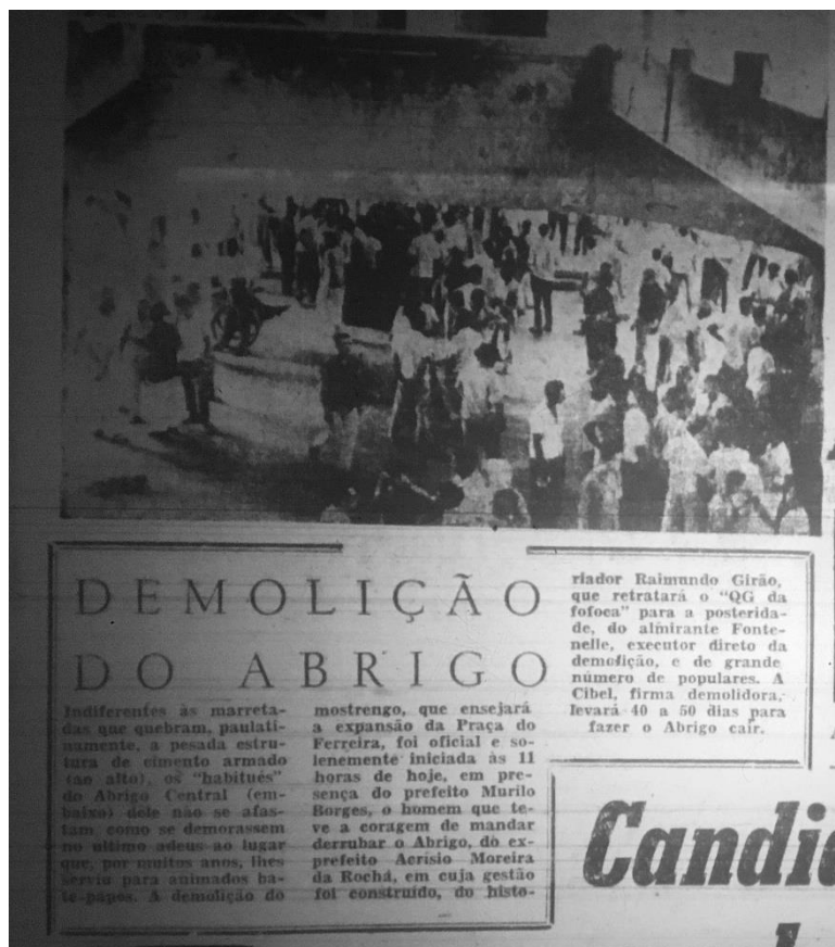
Figura 3.27 - Demolição do Abrigo Central noticiada no jornal O Povo.
