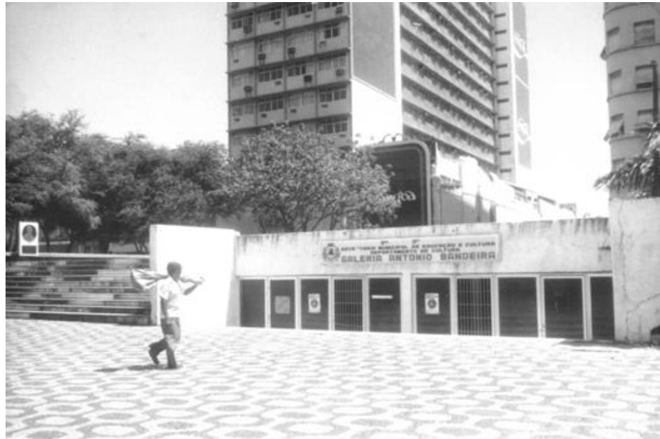
Figura 3.43 - Vista da Galeria Antônio Bandeira a partir do interior da Praça. Ao fundo, no canto direito, percebe-se parte do Cine São Luiz.
