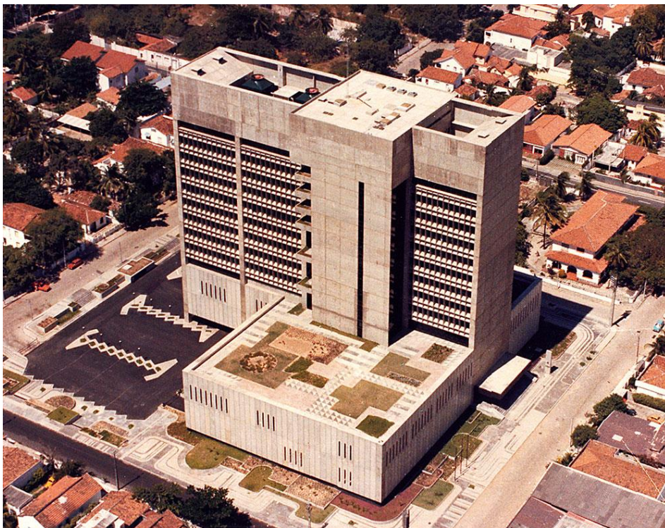
Figura 4.26 - Jardins do edifício-sede do Ministério da Fazenda, em Fortaleza. Projeto de arquitetura de Acácio Gil Borsó e paisagismo de Roberto Burle Marx.
