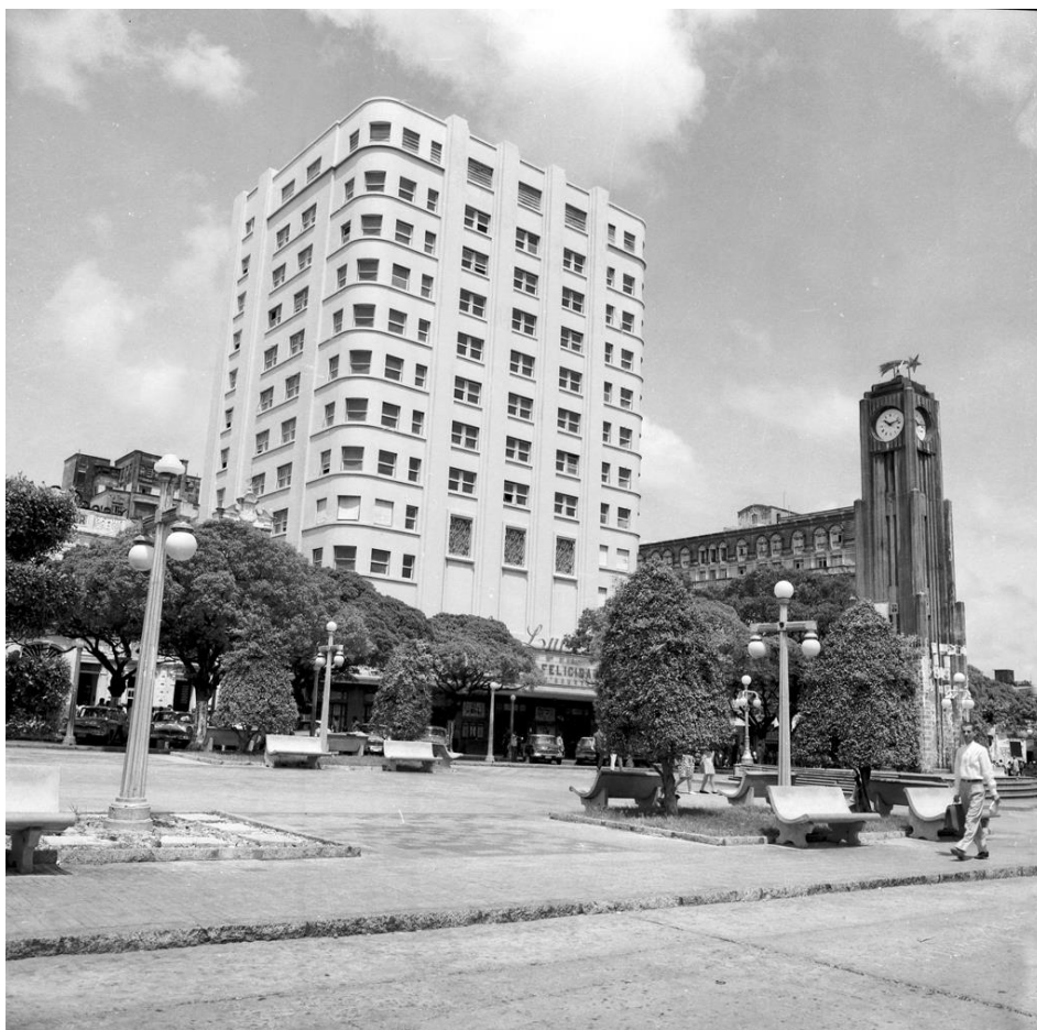
Figura 4.61 - Postes de ferro com luminária em globo de vidro leitoso, década de 1960.
