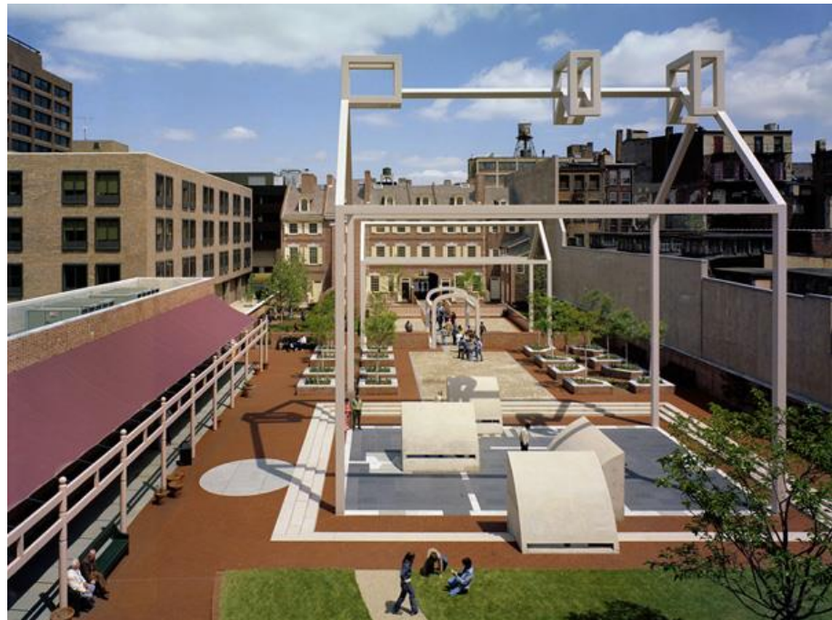
Figura 4.2 - Franklin Court, Filadélfia. Projeto dos arquitetos Denise Scott-Brown e Robert Venturi. Percebe-se a referência histórica às edificações que foram demolidas por meio da planta baixa no piso e das estruturas metálicas que simulam as casas.
