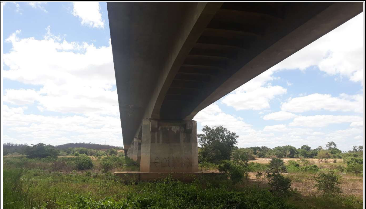
Fotográfica 03 – vista inferior da ponte.
