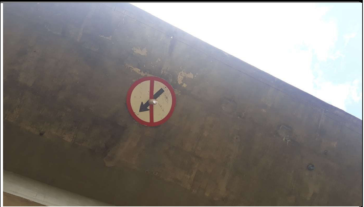
Fotográfica 07 – recuperação da drenagem pós ataque.
