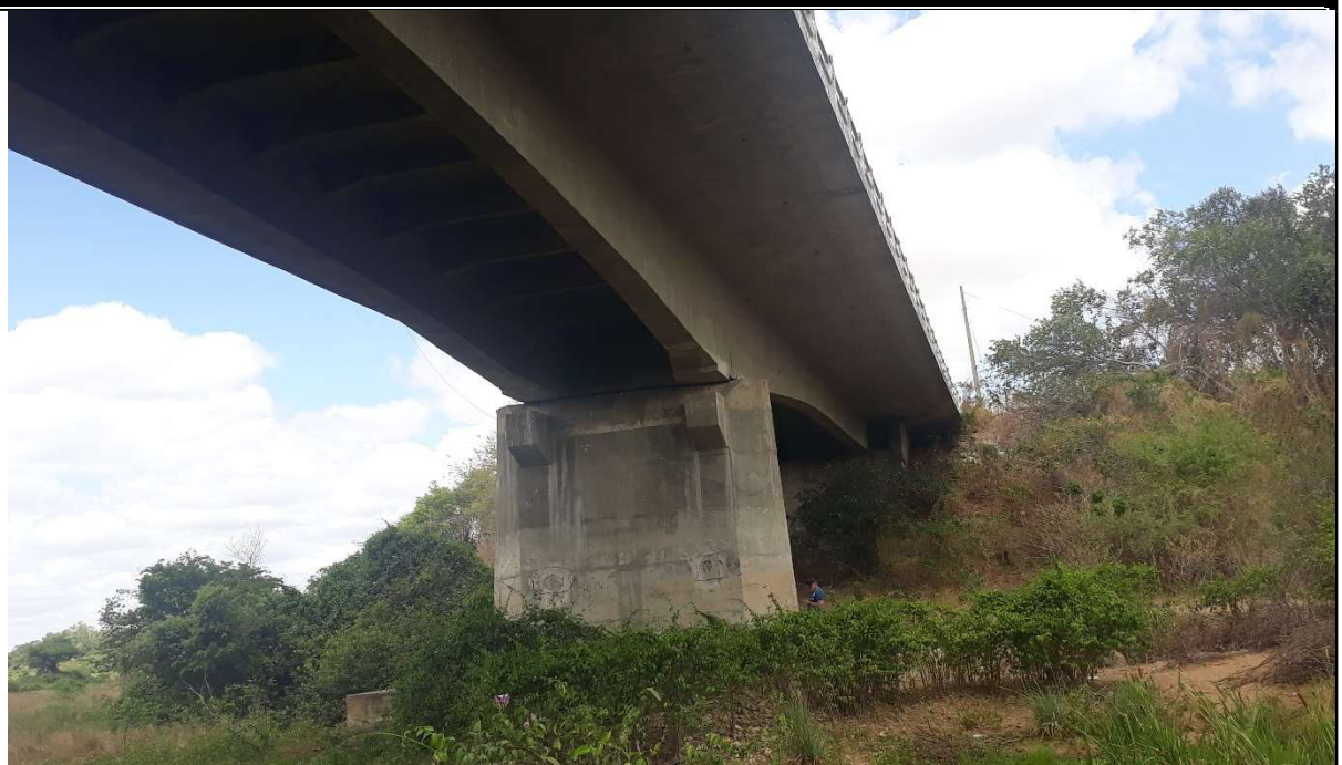
Fotográfica 05 – pilar e encontro da ponte.
