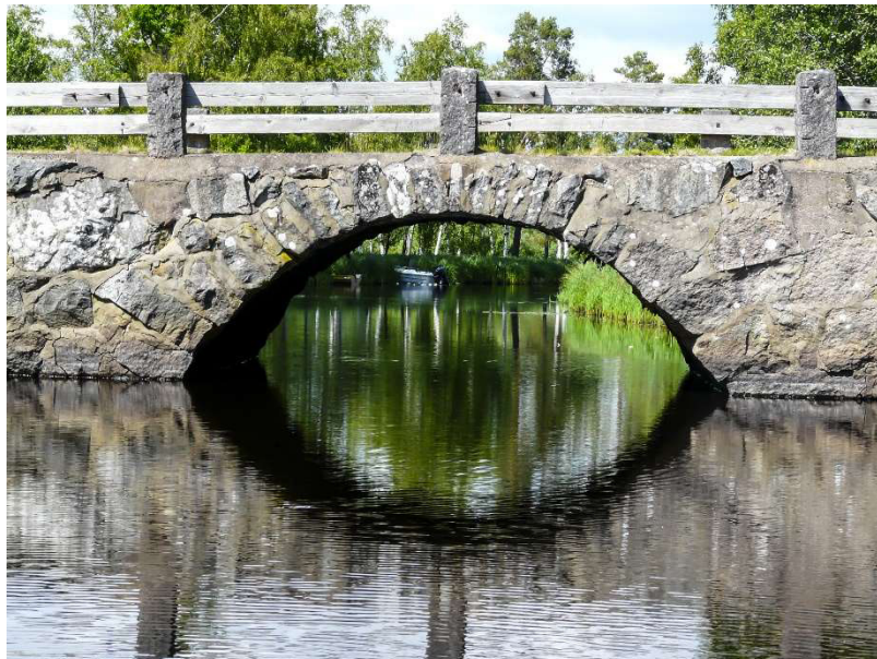
Figura 1 - Ponte em pedra. Fonte: Pixabay - Günter Rohe
