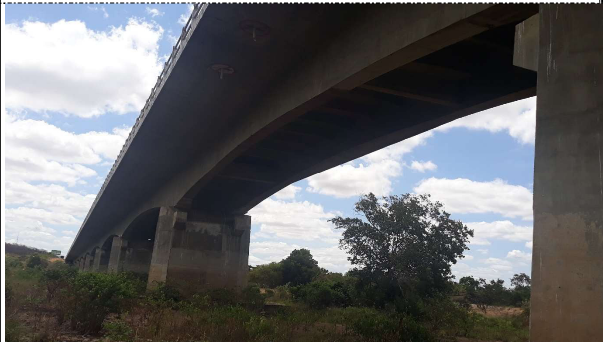
Fotográfica 04 – vista inferior da ponte.
