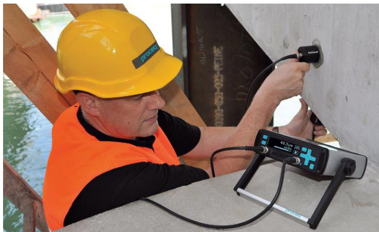
Figura 3.9: Aplicação do método de ultrassom em estrutura de concreto.
