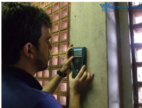
Figura 3.10: Ensaio de pacometria aplicado em uma estrutura de concreto.
