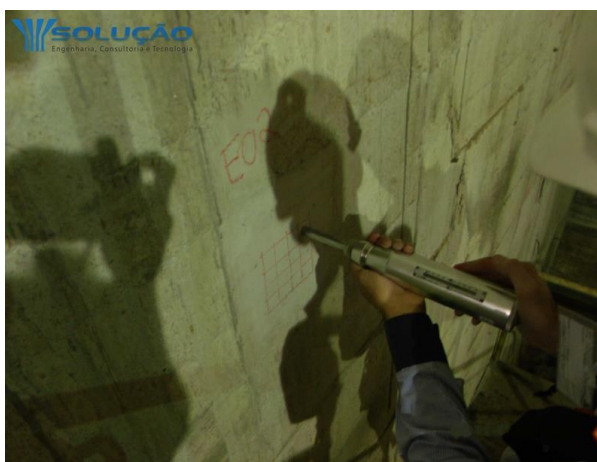
Figura 3.16: Ensaio de esclerometria aplicado a uma estrutura de concreto.
