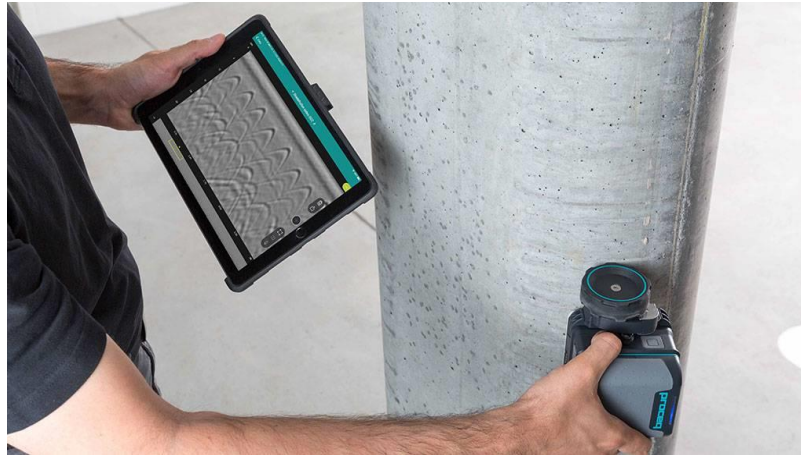
Figura 3.12: Geo Radar Proceq GPR sendo aplicado a uma estrutura de concreto
