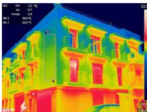
Figura 3.11: Termografia infravermelha em uma estrutura de concreto.
