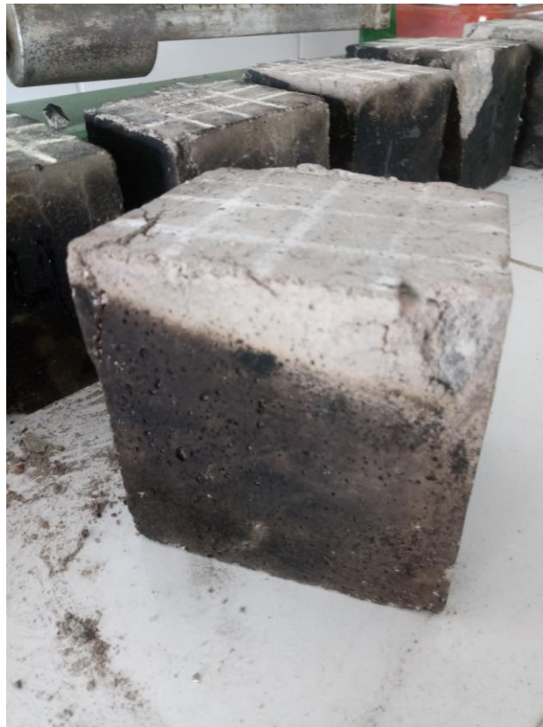
Anexo A.2: Concreto degradando superficialmente após impactos do esclerômetro.
