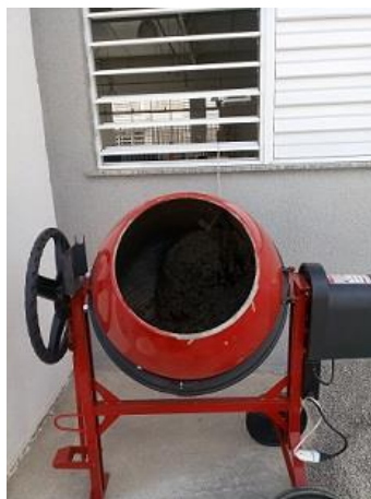
Figura 4.5: Mistura do concreto em betoneira.
