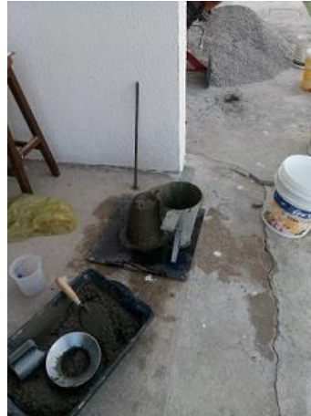
Figura 4.7: Abatimento do concreto produzido.
