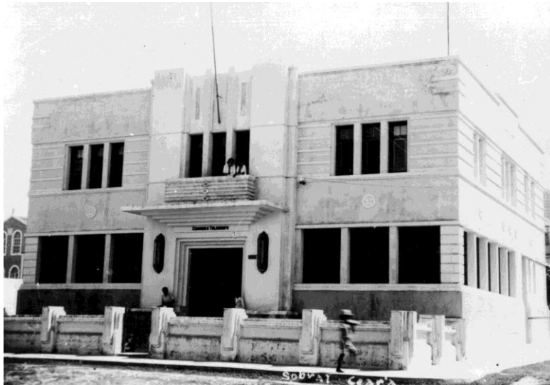
Fig. 69 – Agência dos Correios e Telégrafos, por volta do início do século XX Fonte: Arquivo IPHAN/CE
