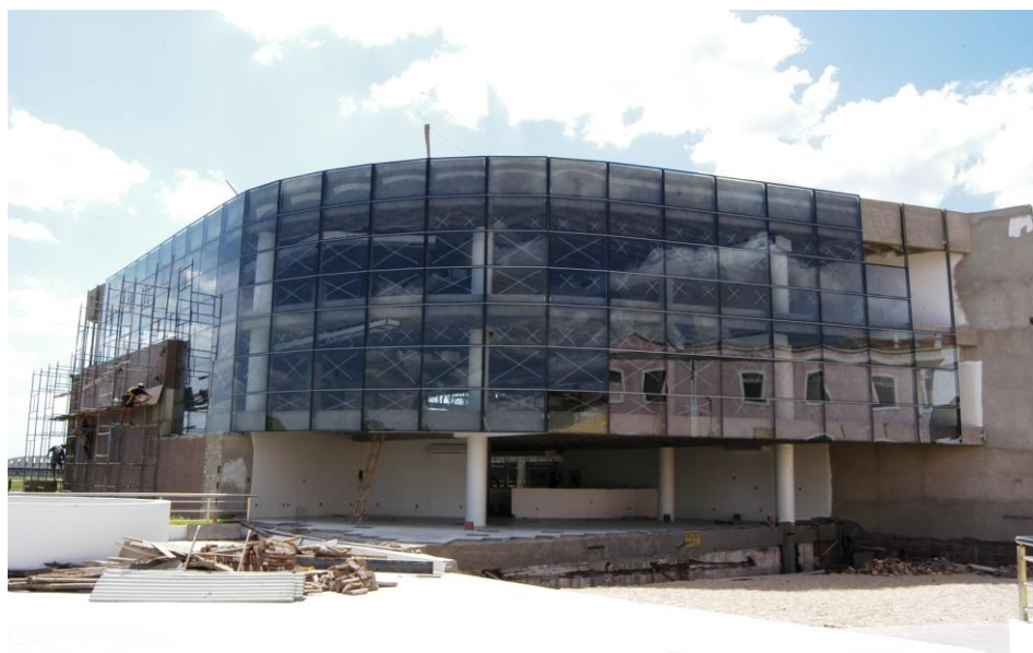
Fig. 134 – Biblioteca Lustosa da Costa em obras Fonte: Acervo Prefeitura Municipal de Sobral Fotografia: Wellington Macedo
