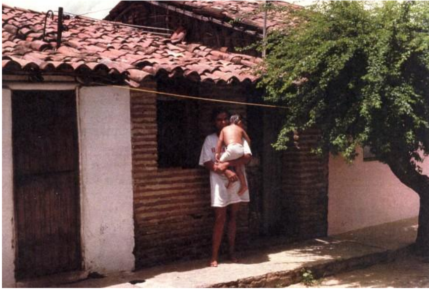
Fig. 76 – Residências precárias situadas na margem esquerda do Rio Acaraú/ Fotografia Gentil Barreira Fonte: Estudo para Tombamento Federal – ETF/Sobral 1997
