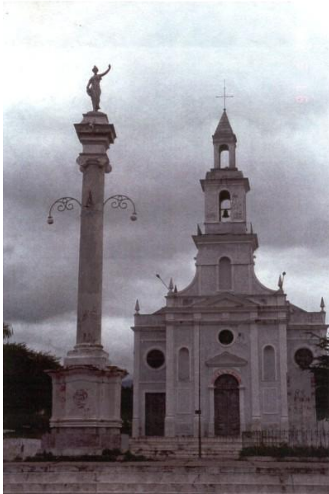
Fig. 82 – Praça do Patrocínio/ Fotografia Gentil Barreira Fonte: Estudo para Tombamento Federal – ETF/Sobral 1997
