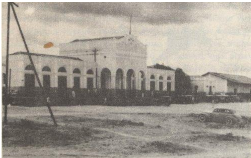
Fig. 74 – Estação Ferroviária de Sobral, por volta do início do século XX Fonte: Arquivo IPHAN/CE
