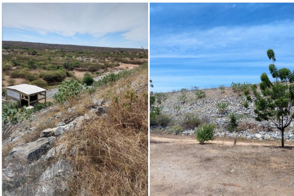
Figura 4.12 – Talude de Jusante, Figueiredo.
