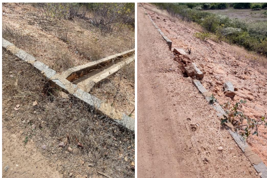
Figura 4.6 – Canaletas, Poço do Barro.
