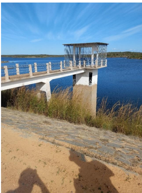
Figura 3.5 – Torre da Tomada d'água da Barragem Poço do Barro.
