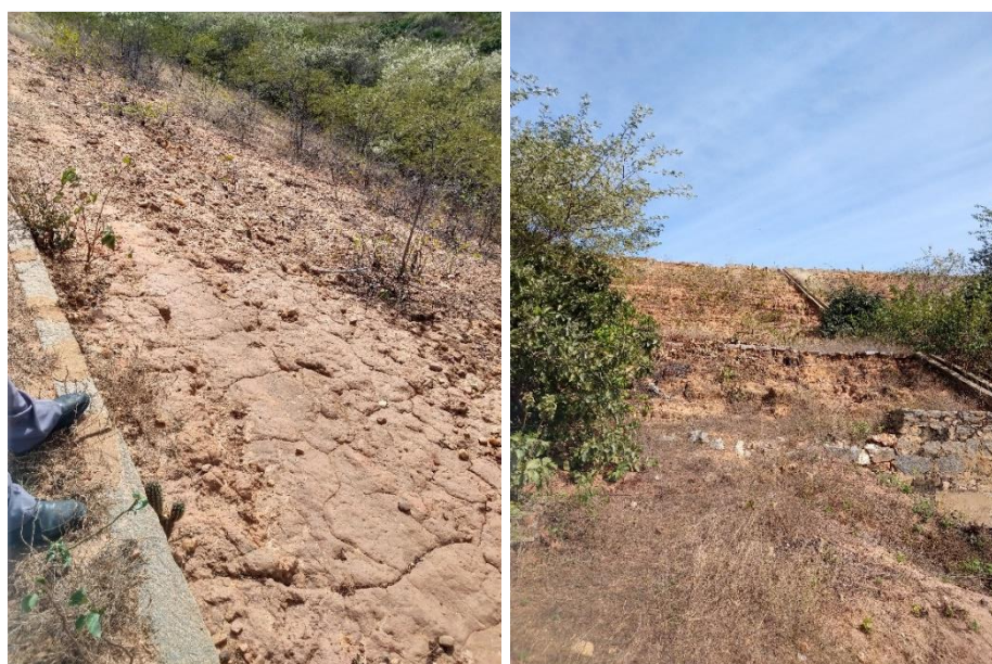
Figura 4.9 – Talude de Jusante, Poço do Barro.
