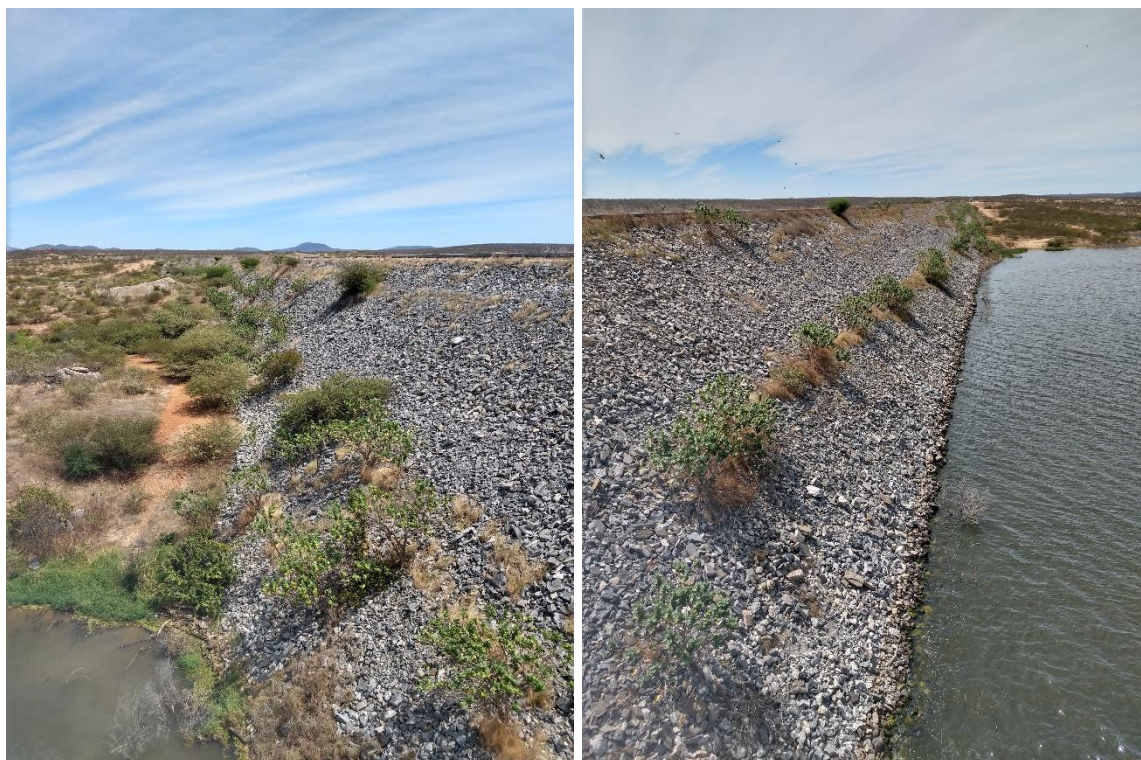
Figura 4.11 – Talude de Montante, Figueiredo.
