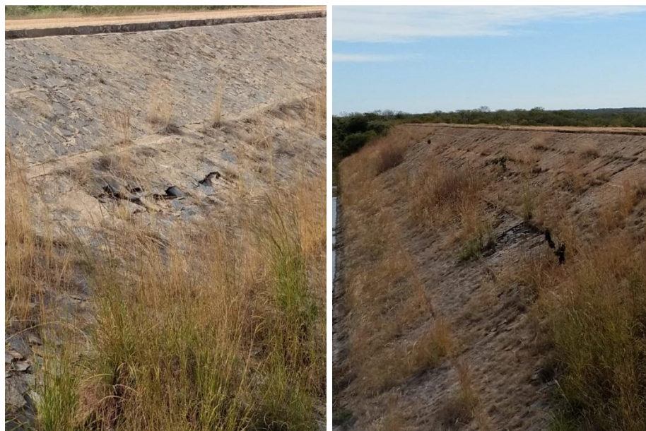
Figura 4.8 – Rip-rap de montante, Poço do Barro.
