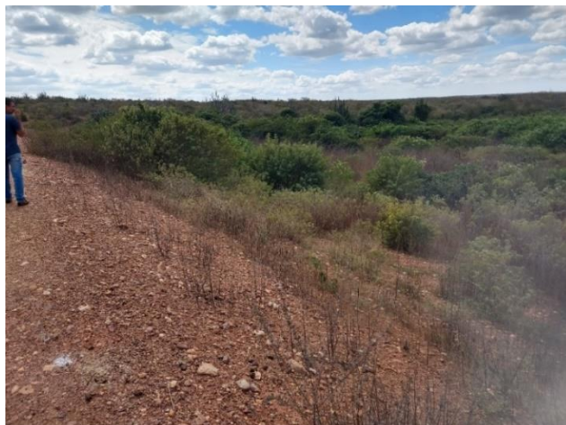
Figura 4.4 – Talude de Jusante, Santo Antônio de Russas.
