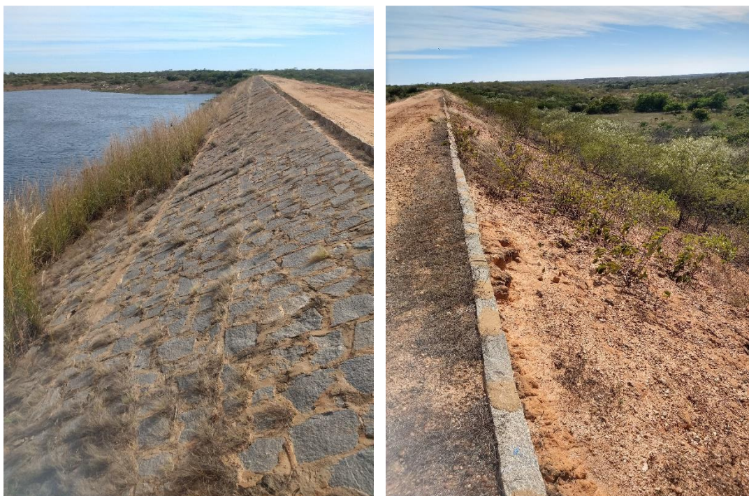
Figura 4.7 – Taludes de (a) Montante e de (b) Jusante, Poço do Barro.
