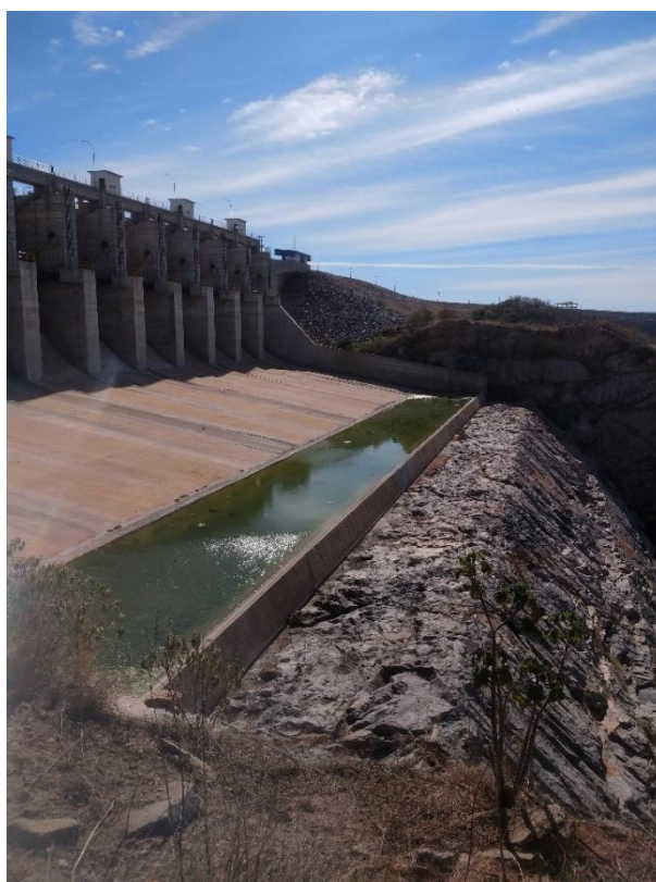
Figura 3.9 – Sangradouro da Barragem Castanhão.
