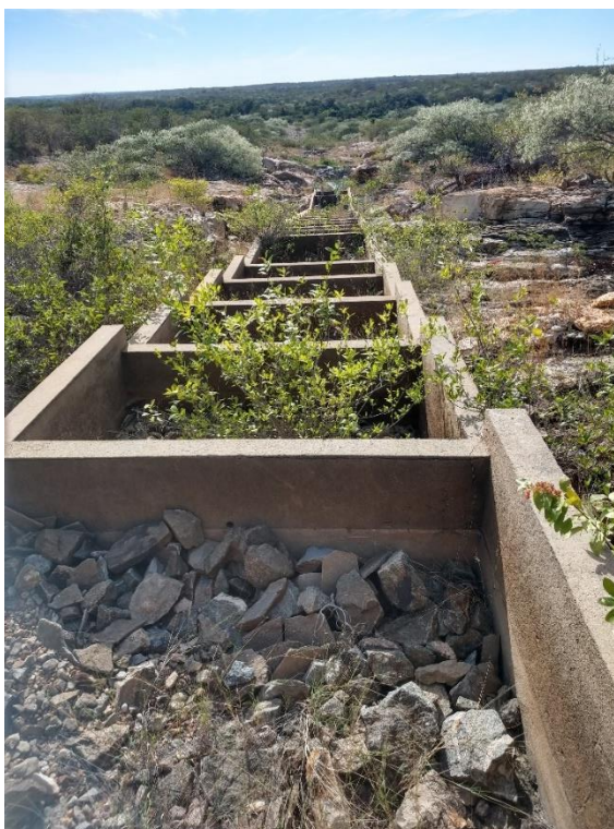
Figura 3.4 – Sangradouro da Barragem Poço do Barro.
