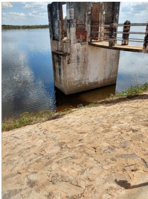
Figura 3.3 – Torre de tomada d'água da Barragem Santo Antônio de Russas.
