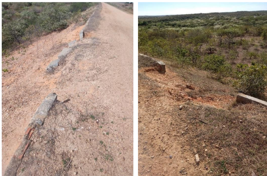
Figura 4.5 – Meio fio a jusante, Poço do Barro.
