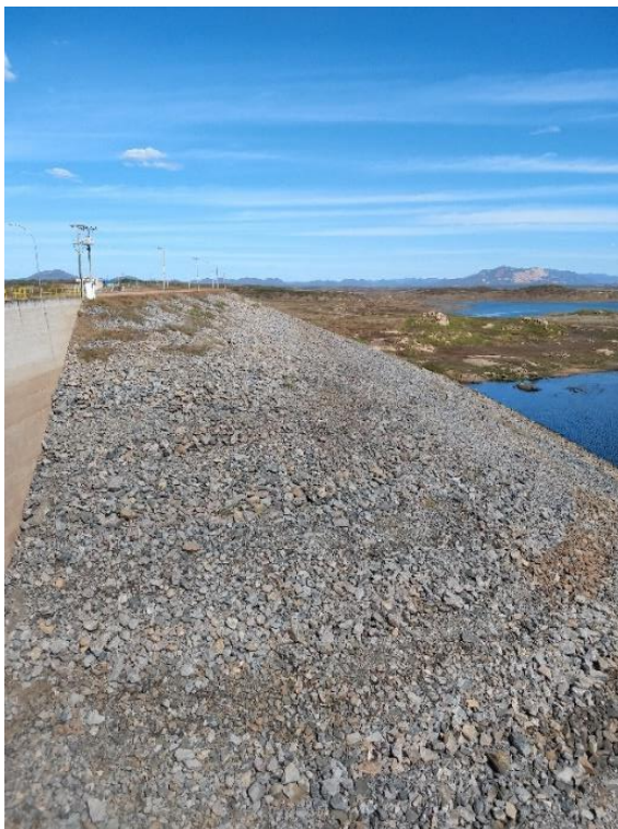
Figura 4.14 – Talude de Montante, Castanhão.
