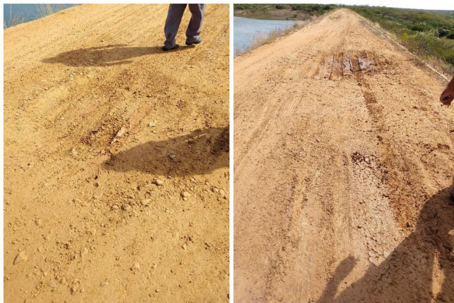
Figura 4.10 – Afundamentos no coroamento, Poço do Barro.
