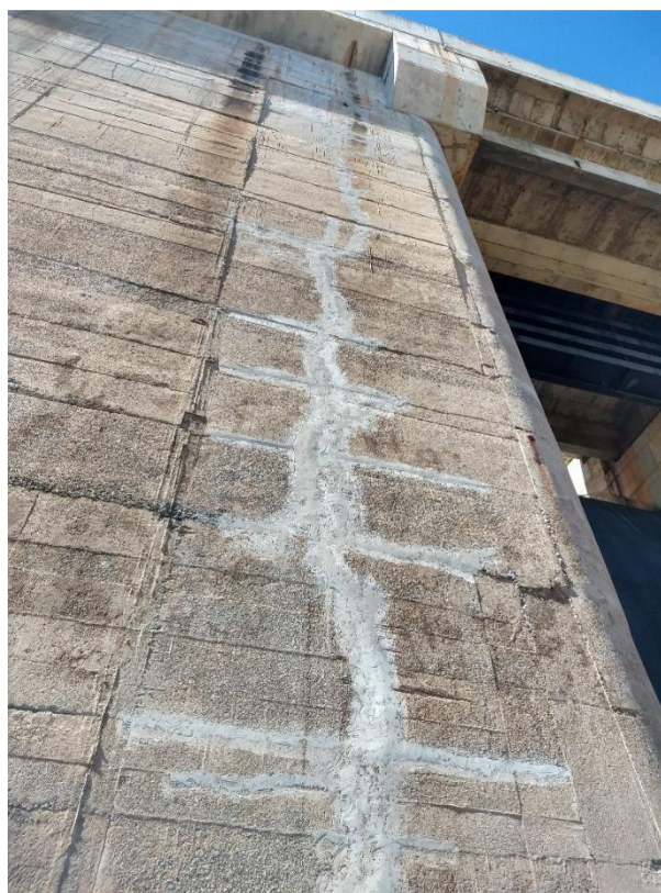
Figura 4.16 – Fissura restaurada, Castanhão.
