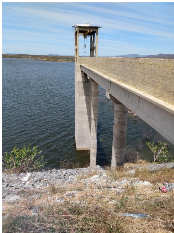
Figura 3.8 – Torre de Tomada d'água da Barragem Figueiredo.
