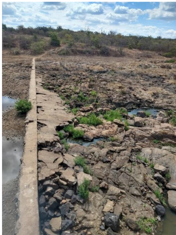
Figura 3.2 – Sangradouro da Barragem Santo Antônio de Russas.
