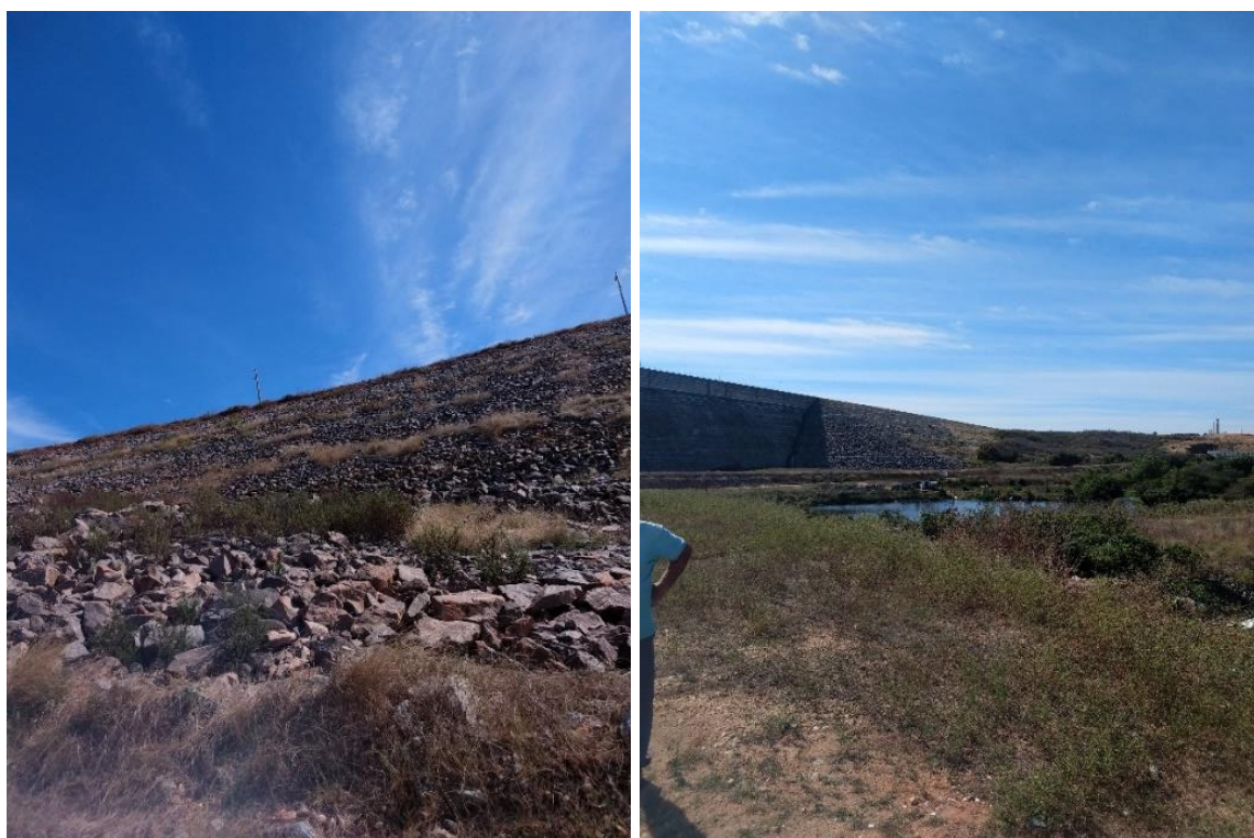
Figura 4.15 – Talude de Jusante, Castanhão.
