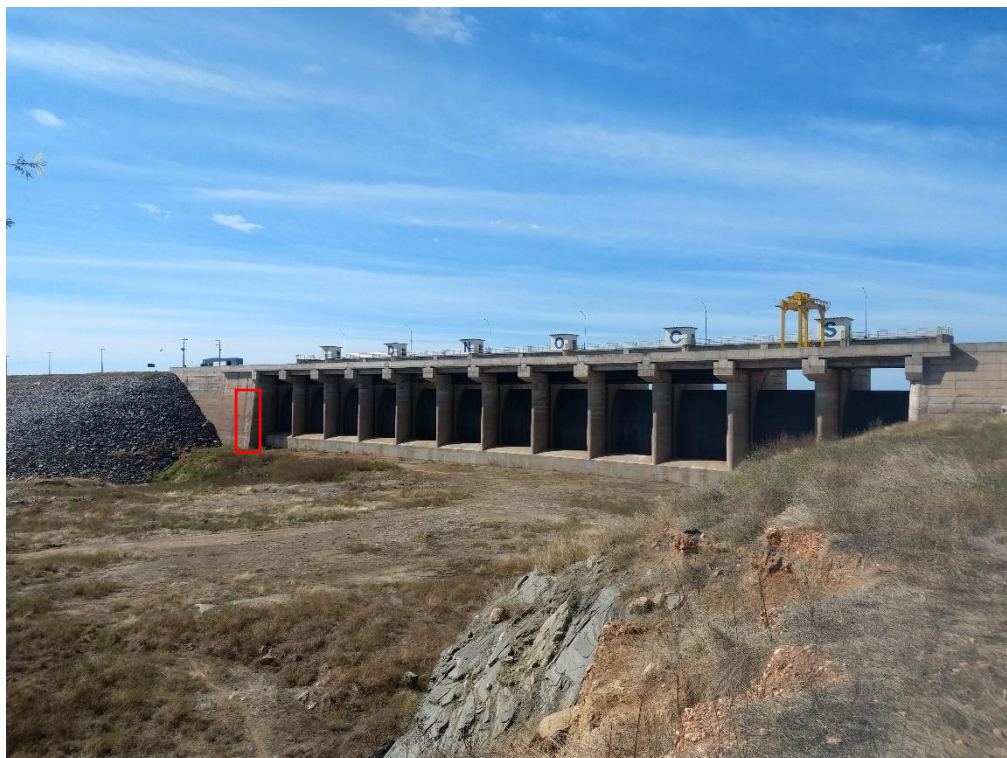
Figura 4.17 – Vista de montante do sangradouro, Castanhão.
