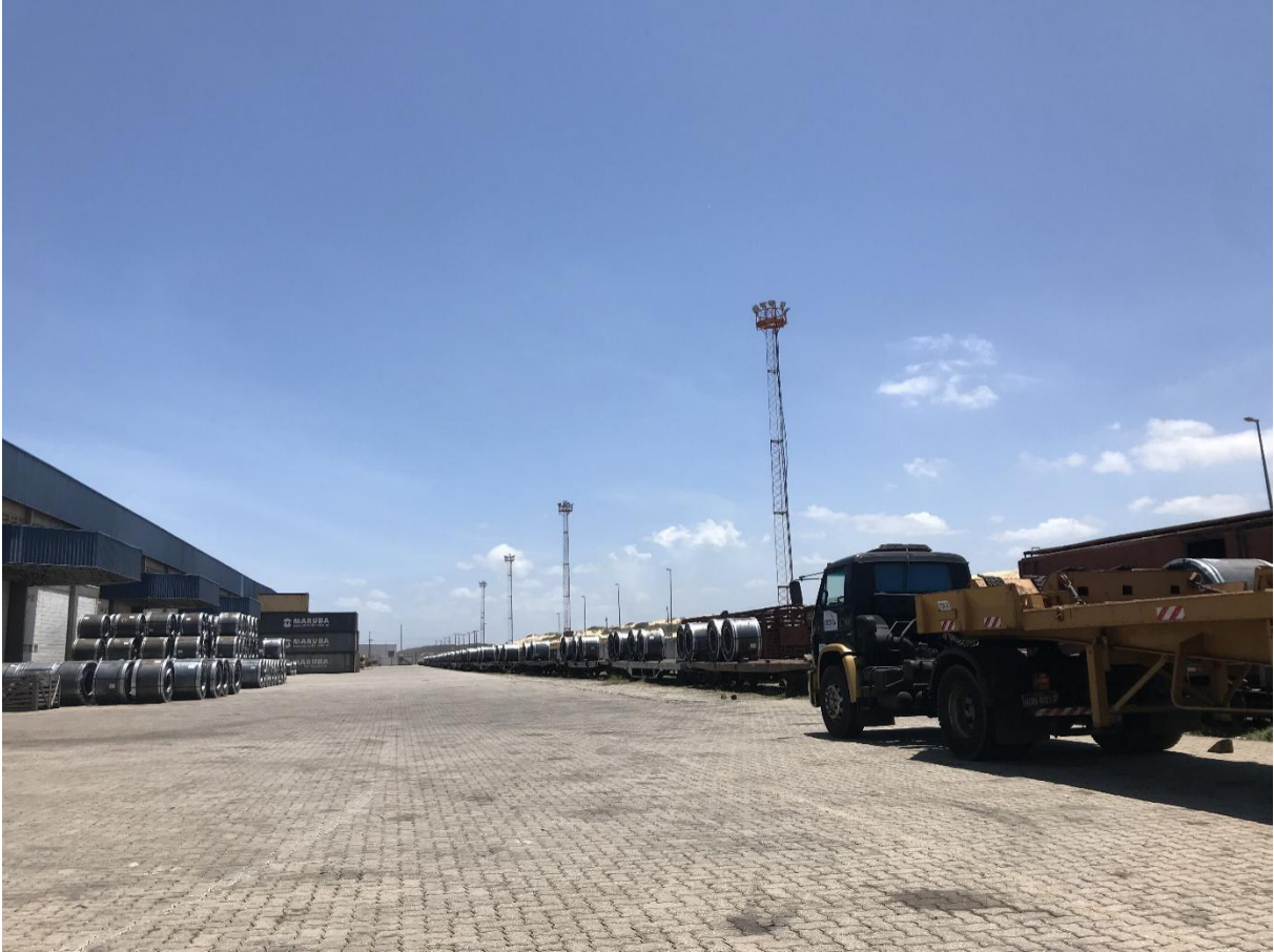
Contêineres no TMUT do Porto do Pecém. Bobinas no Porto do Pecém.
