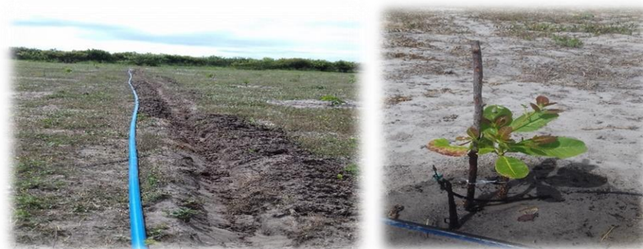
Figura 6 - Instalação do sistema de irrigação por microaspersão
