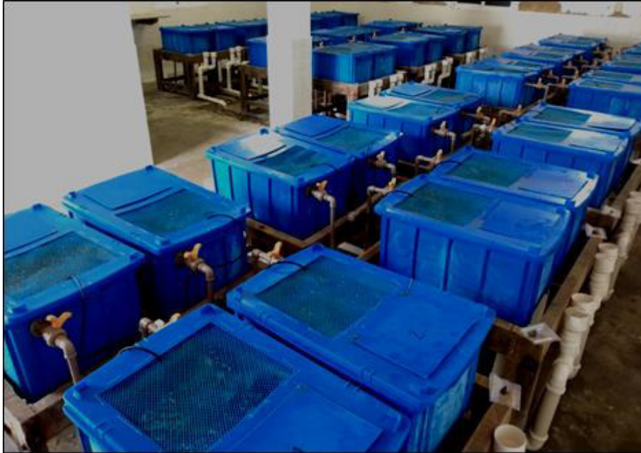
Figura 2 – Sistema de cultivo em 44 tanques, com volume de 61 L cada, com área de fundo de 0,2 m 2 operando sob regime de recirculação de águas.
