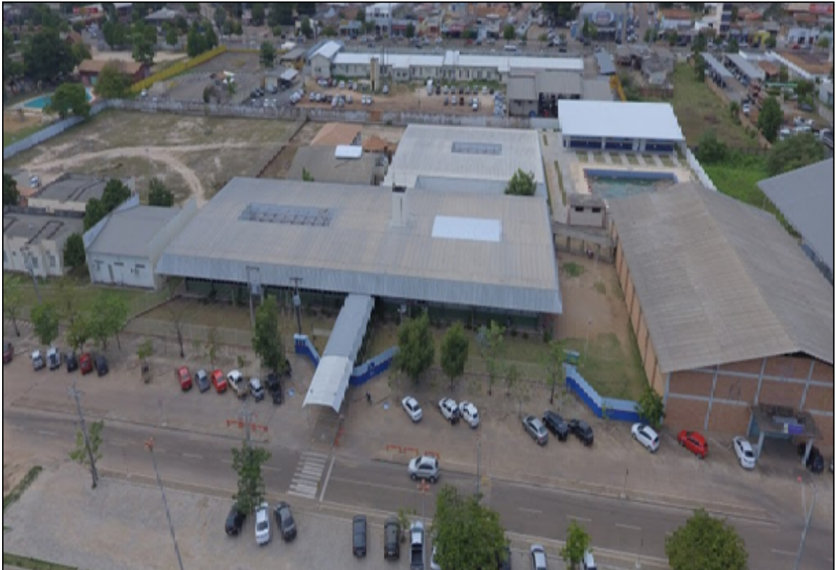
Figura 18 – Colégio de Aplicação da Universidade Federal de Roraima
