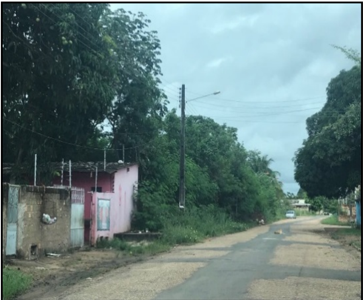
Figura 21 – Rua sem infraestrutura adequada no Bairro Aeroporto
