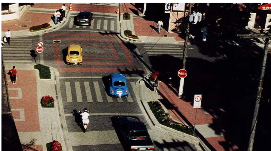
Figura 6.3: Estreitamento de pista e alargamento das calçadas em Blumenau-SC.
