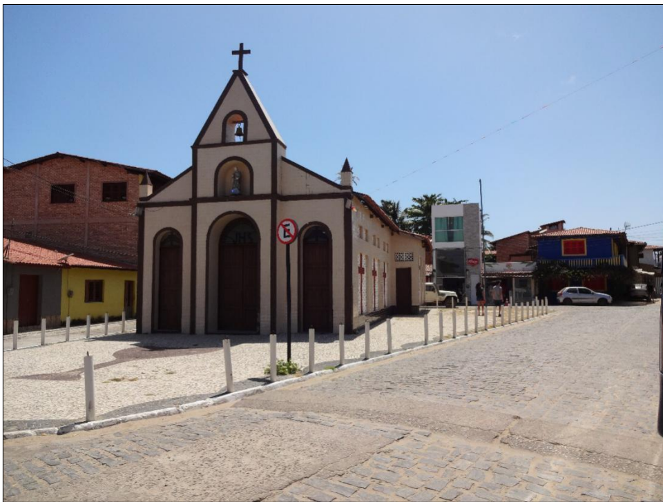
Figura 17 - Núcleo central de Flecheiras (área da Igreja de São Pedro modificada em relação à década de 70).
