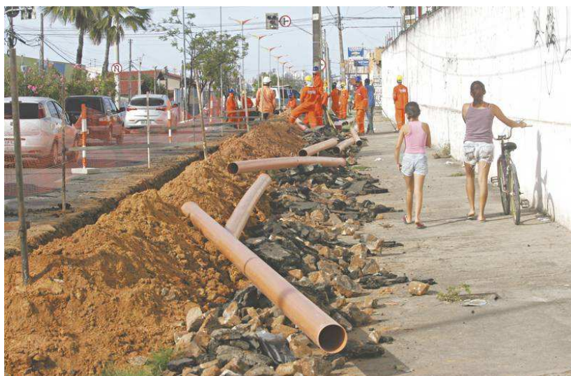
Figura 6 - Instalação de rede de esgotamento sanitário pelo método destrutivo
