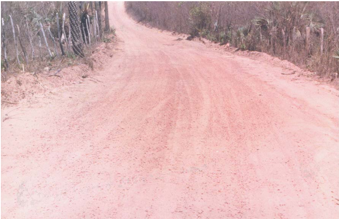
Figura 3.2: Vista de um Trecho de Estrada Não Pavimentada no Período de Seca
