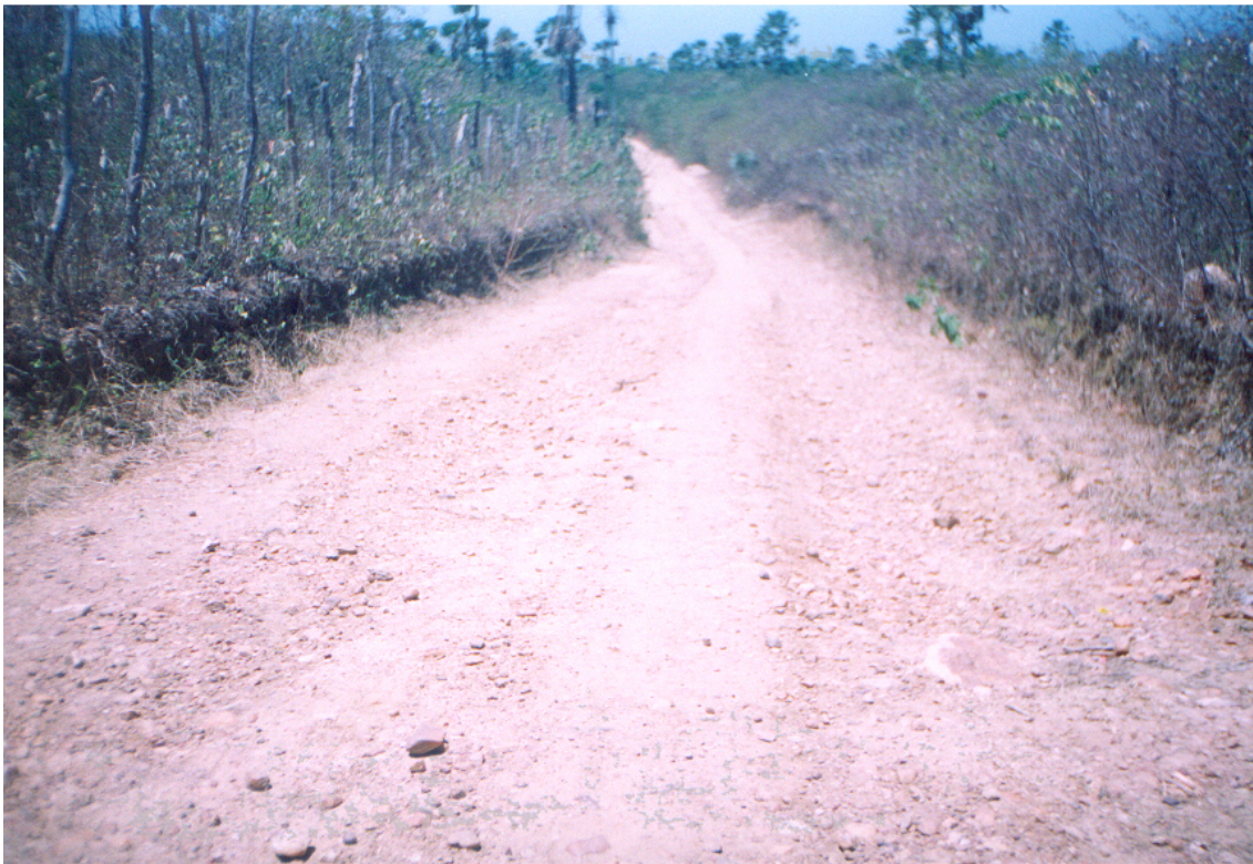
Figura 3.11: Ocorrência de Trilhas de Roda em Greide “Encaixado”
