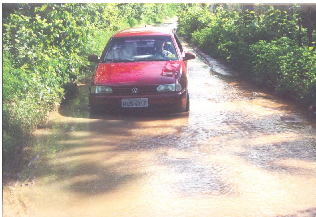
Figura 5.36: Formação de “Piscinas” no Leito Estradal.
