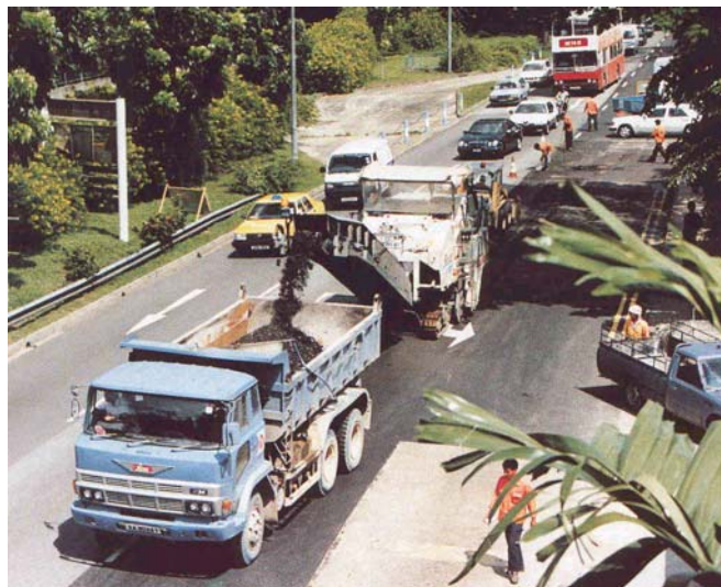
Figura 2.5: Fresagem a frio em via urbana
