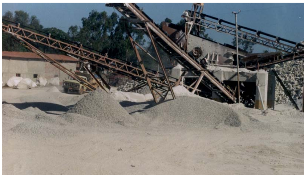
Figura 3.6: Local de coleta dos agregados (pedreira comercial em Itaitinga)
