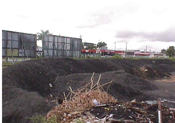
Figura 3.2: Estocagem do fresado
