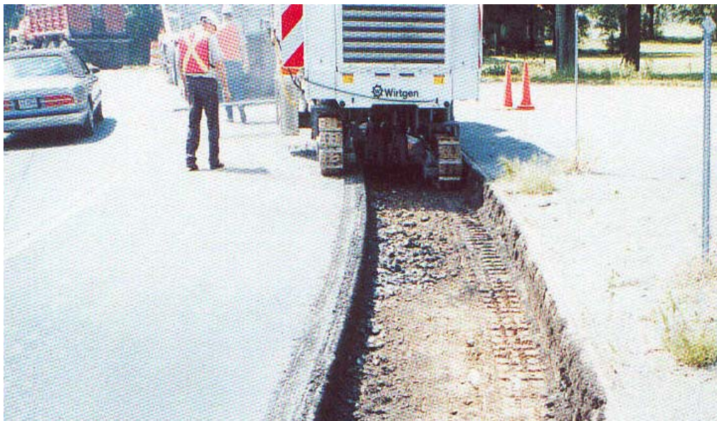
Figura 2.6: Reciclagem com fresagem profunda ( Full Depth )
