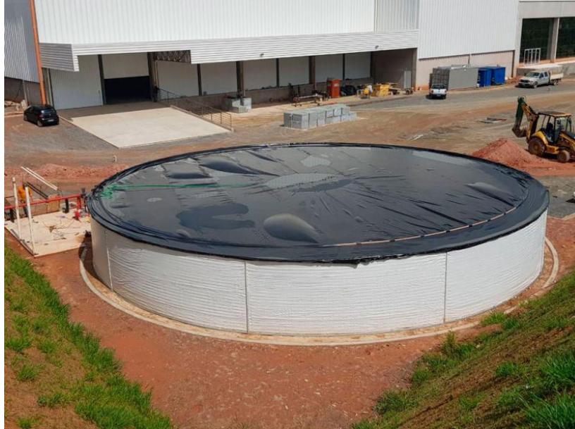
Figura 11 - Reservatório de água da chuva, de paredes metálicas.
