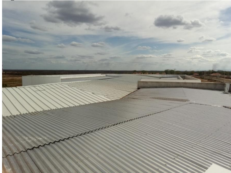
Figura 18 - Coberta do Bloco Acadêmico.
