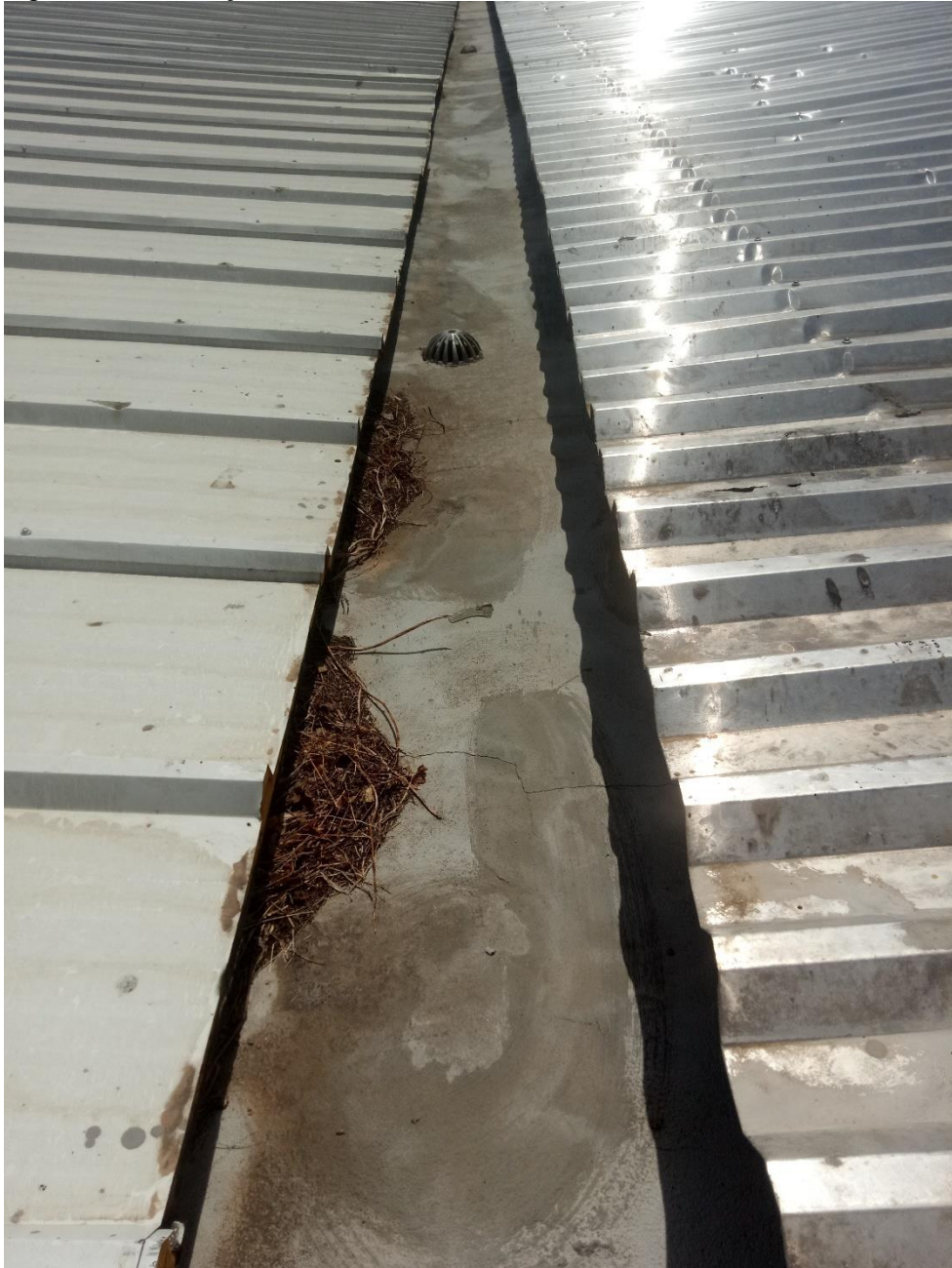
Figura 19 - Condições instaladas da calhas – Bloco Acadêmico
