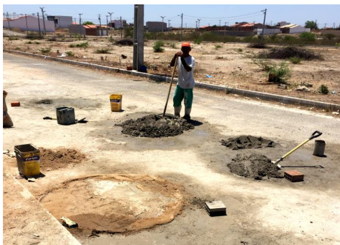
Figura 33 - Mistura manual do concreto na obra C1
