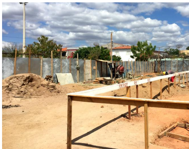
Figura 19 - Armazenamento de materiais na obra A2
