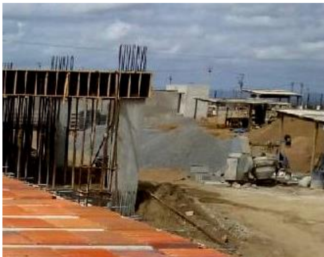
Figura 18 - Armazenamento de materiais na obra A1
