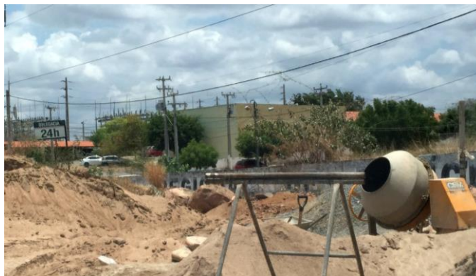
Figura 20 - Armazenamento de materiais na obra A3
