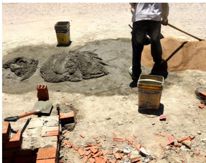
Figura 32 - Mistura manual do concreto na obra B3
