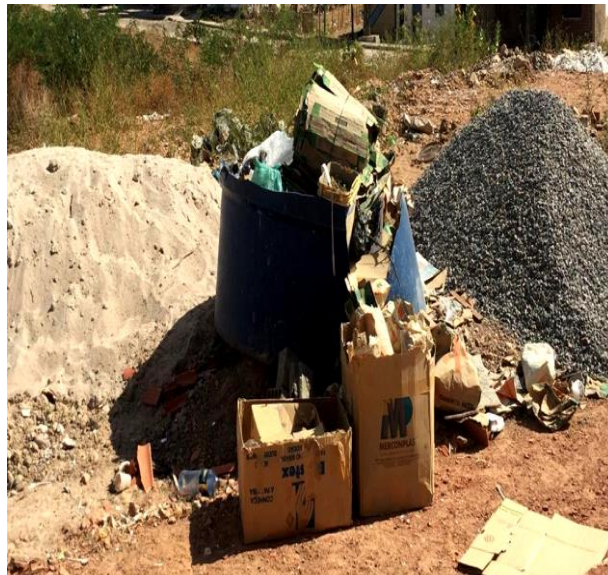
Figura 25 - Armazenamento de materiais na obra C2
