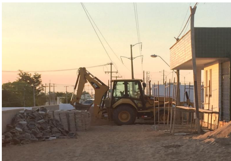
Figura 30 - Trator retroescavadeira utilizado no transporte de concreto.
