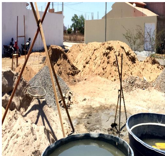
Figura 26 - Armazenamento de materiais na obra C3
