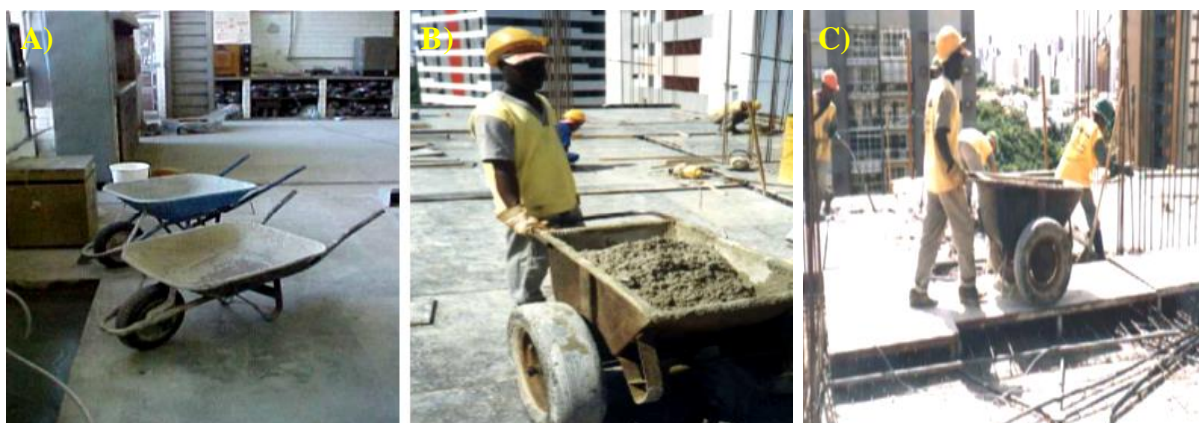
Figura 43 - Equipamentos para transporte horizontal de concreto: A) carrinhos de mão; B) jericica; C) passarelas de movimentação de concreto.
