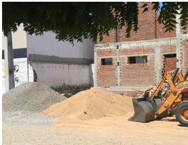
Figura 22 - Armazenamento de materiais na obra B2
