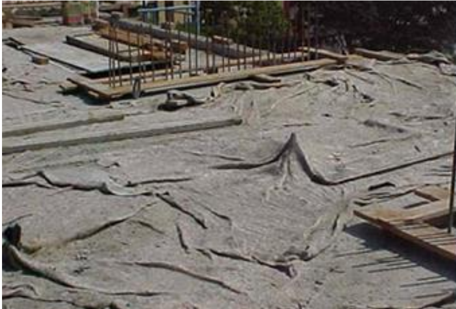
Figura 46 - Cura por recobrimento úmido de laje.
