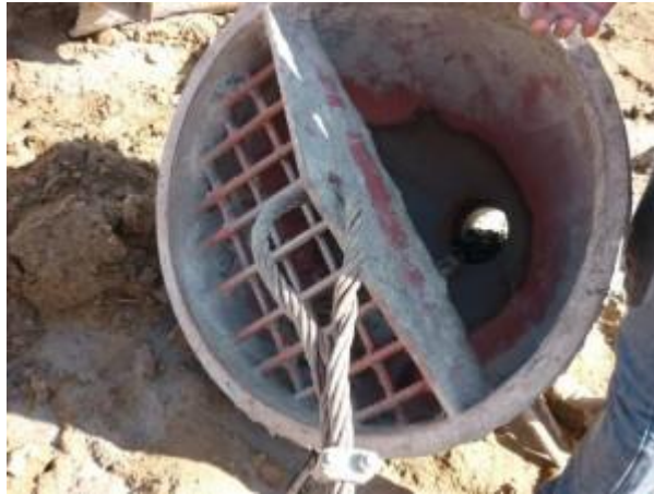
Figura 44 - Funil para lançamento de concreto
