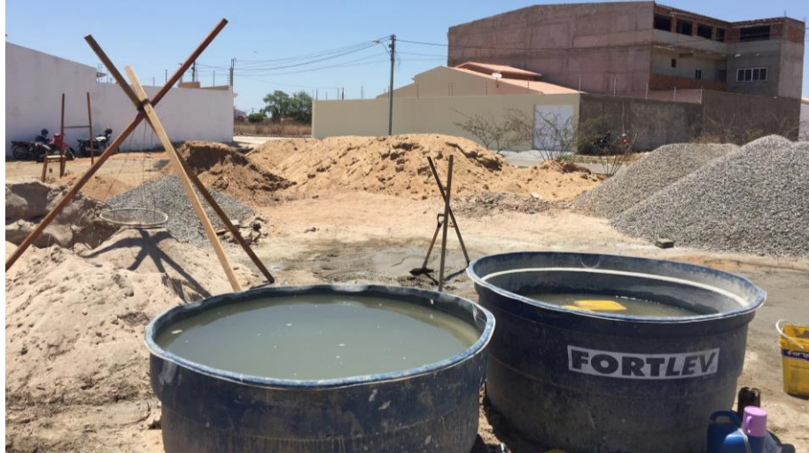
Figura 34 - Local de armazenamento e mistura de materiais componentes do concreto.
