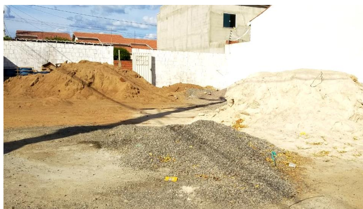
Figura 23 - Armazenamento de materiais na obra B3
