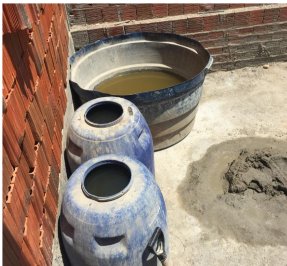
Figura 31 - Armazenamento de água para amassamento da obra.
