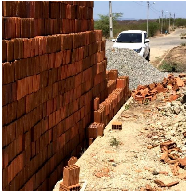
Figura 24 - Armazenamento de materiais na obra C1
