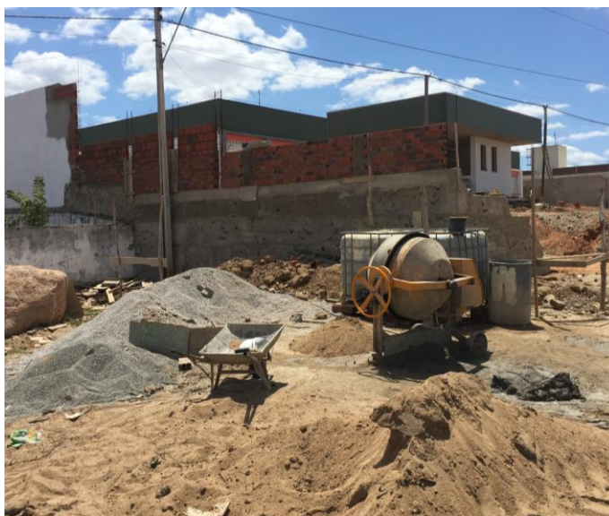
Figura 29 - Estocagem de materiais feita na obra A3.
