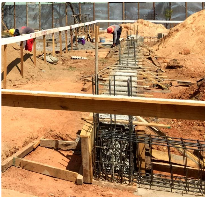
Figura 28 - Elemento de fundação ainda com fôrmas
