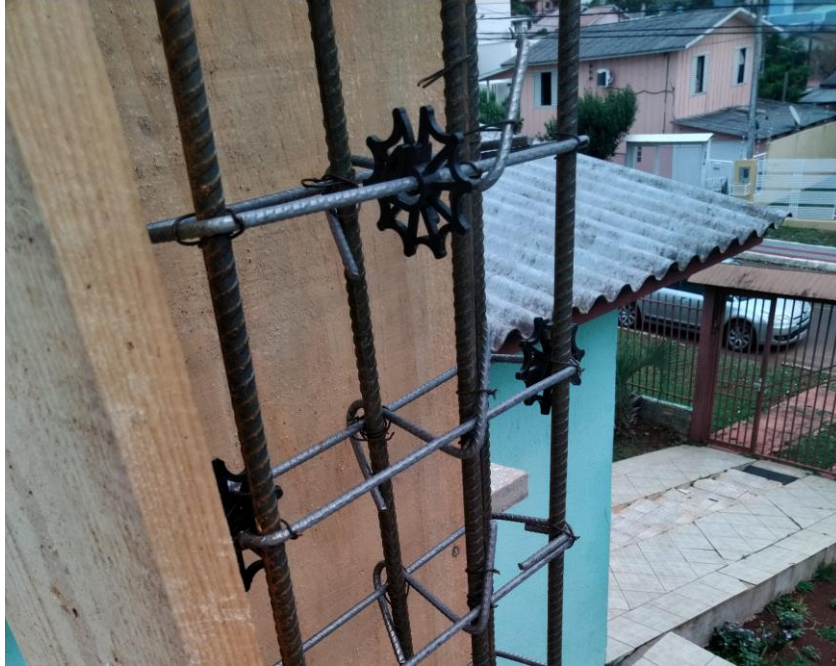
Figura 39 - Espaçadores em pilar
