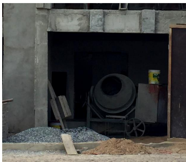
Figura 21 - Armazenamento de materiais na obra B1
