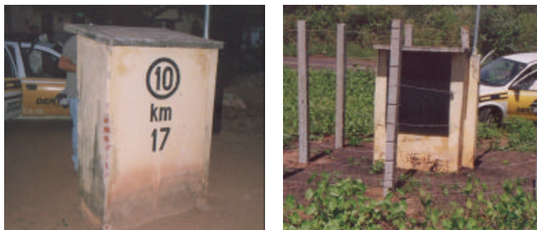
Figura 4.2: Postos de Contagem Permanentes Protegidos por Abrigos de Concreto
