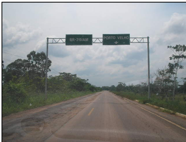
Figura 3. 2: BR 319 / km13 – Revestimento sendo recuperado.
