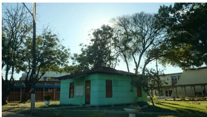
Figura 1 – A casa verde da química.
