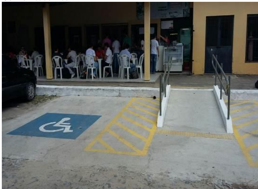
Figura 26 - Vaga de estacionamento acessível e rampa na cantina do Centro Acadêmico.
