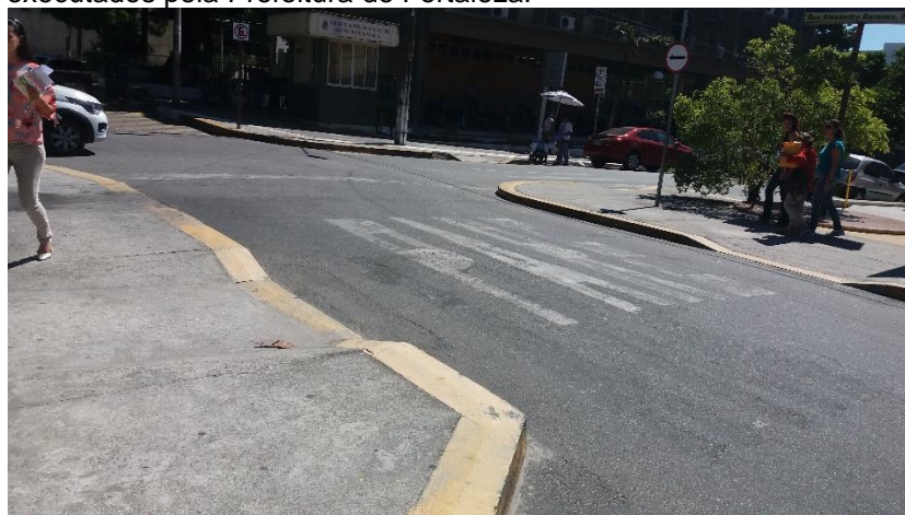
Figura 35 - Avanço das esquinas com construção de rebaixos executados pela Prefeitura de Fortaleza.
