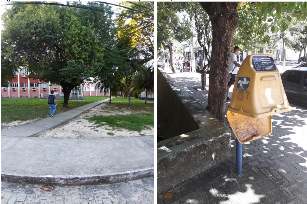
Figura 98 - Calçada externa sem referência de rota para pessoas com deficiência visual (esquerda). Figura 99 - Elemento suspenso sem sinalização alerta (direita).
