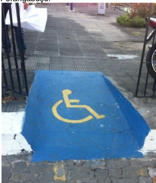
Figura 18 - Rampa executada anterior ao Plano de Acessibilidade no campus do Porangabuçu.
