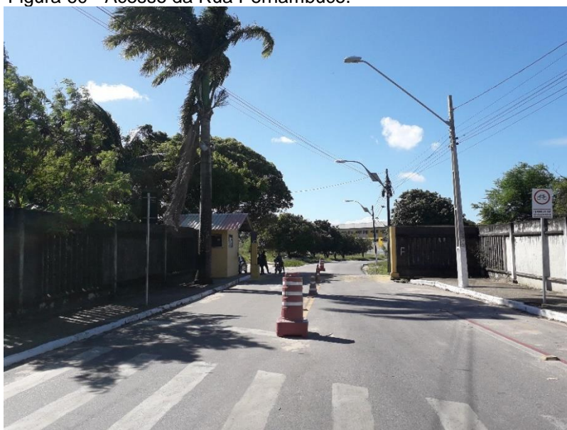
Figura 60 - Acesso da Rua Pernambuco.
