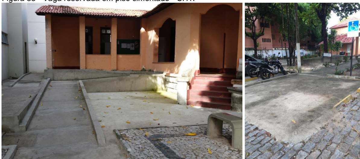
Figura 37 - Rampa construída na Casa de Cultura Francesa. Figura 38 - Vaga reservada em piso cimentado - CH1.
