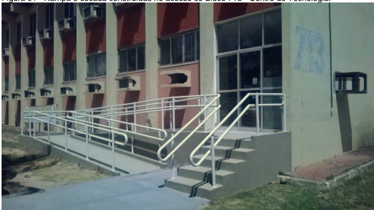
Figura 91 - Rampa e escada construídas no acesso ao Bloco 713 - Centro de Tecnologia.
