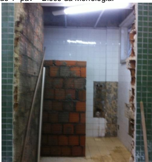
Figura 27 - Reforma no banheiro masculino do 1º pav – Bloco da Morfologia.
