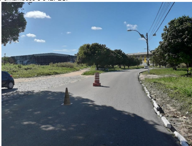
Figura 63 - Via sem calçadas no trecho entre o acesso da Rua Pernambuco e o IEFES.
