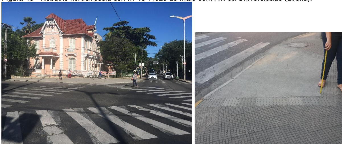
Figura 46 - Rebaixo na travessia da Av. 13 Treze de Maio com Av. da Universidade (direita).
