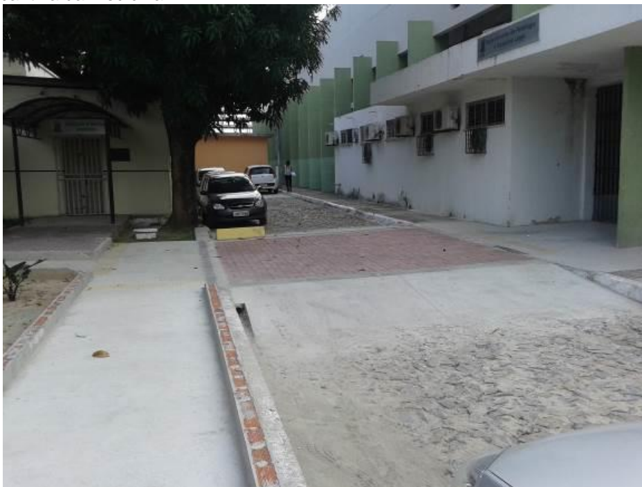
Figura 19 - Passagem elevada executada entre o Bloco de Patologia e a cantina da Medicina.
