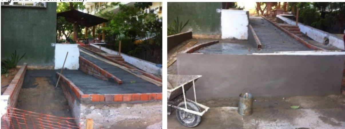
Figura 20 - Construção de rampa no Bloco da Morfologia (esquerda). Figura 21 - Idem (direita).
