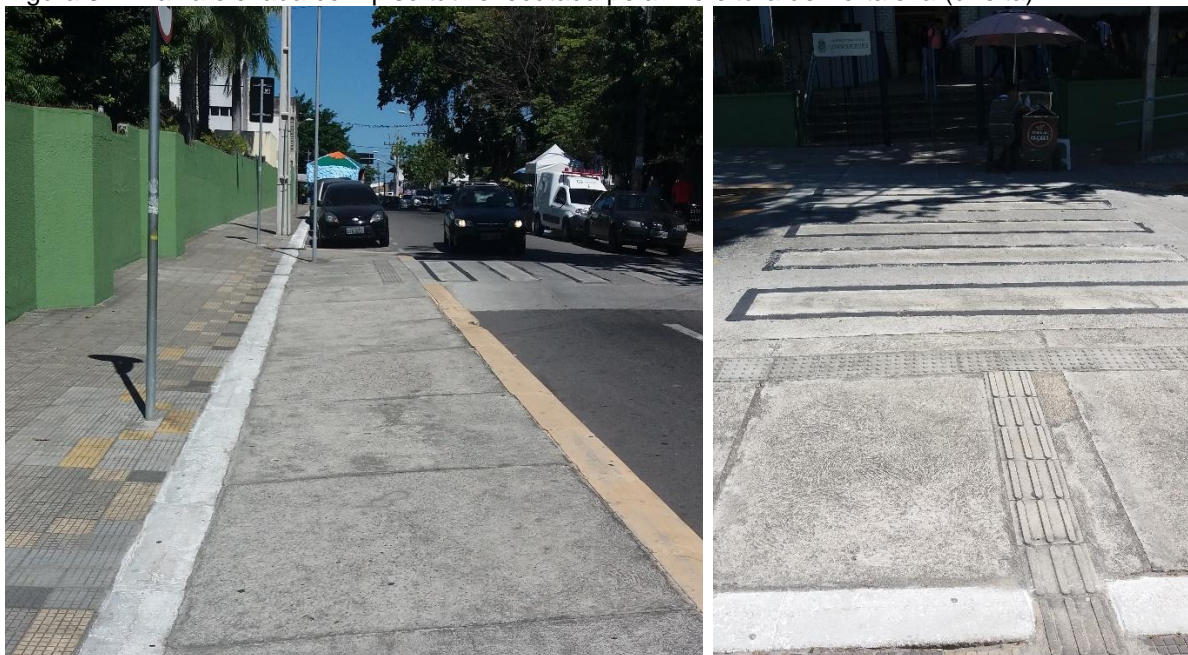
Figura 33 - Alargamento de calçada e faixa elevada executados pela Prefeitura de Fortaleza (esquerda). Figura 34 - Faixa elevada com piso tátil executada pela Prefeitura de Fortaleza (direita).
