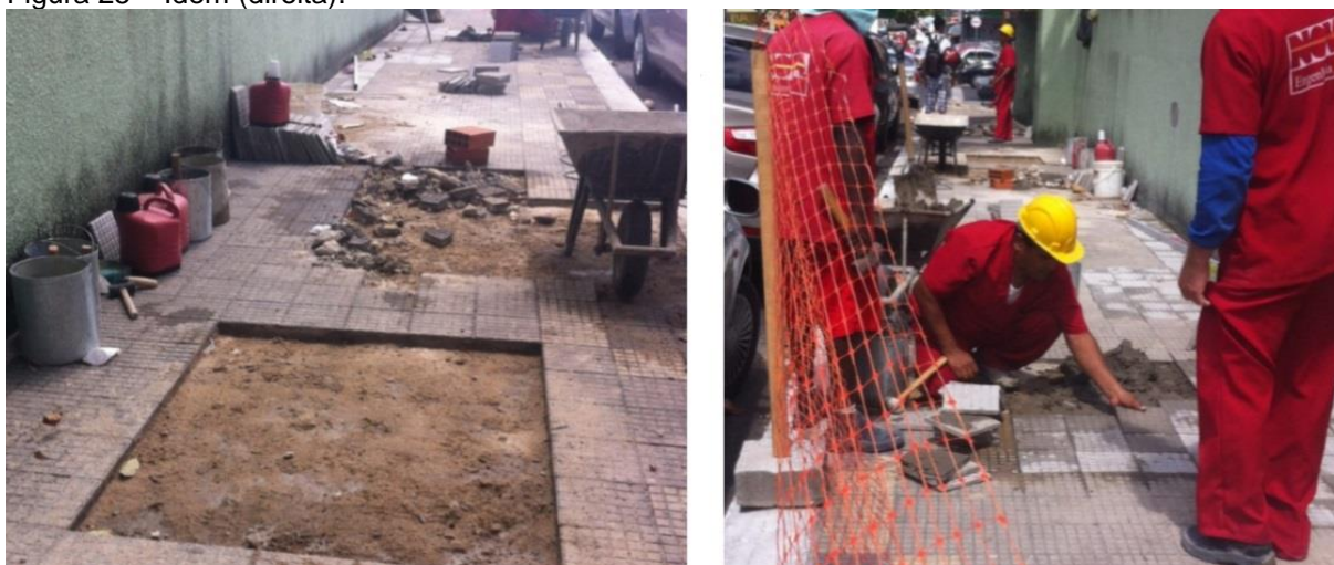
Figura 24 - Assentamento de ladrilhos no passeio externo da Rua Monsenhor Furtado (esquerda). Figura 25 – Idem (direita).
