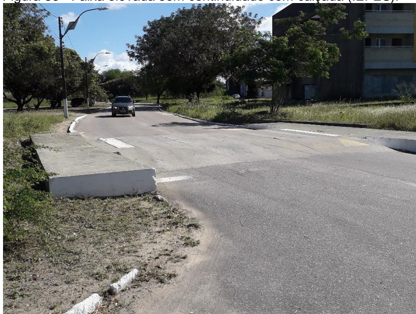
Figura 86 - Faixa elevada sem continuidade com calçada (IEFES).
