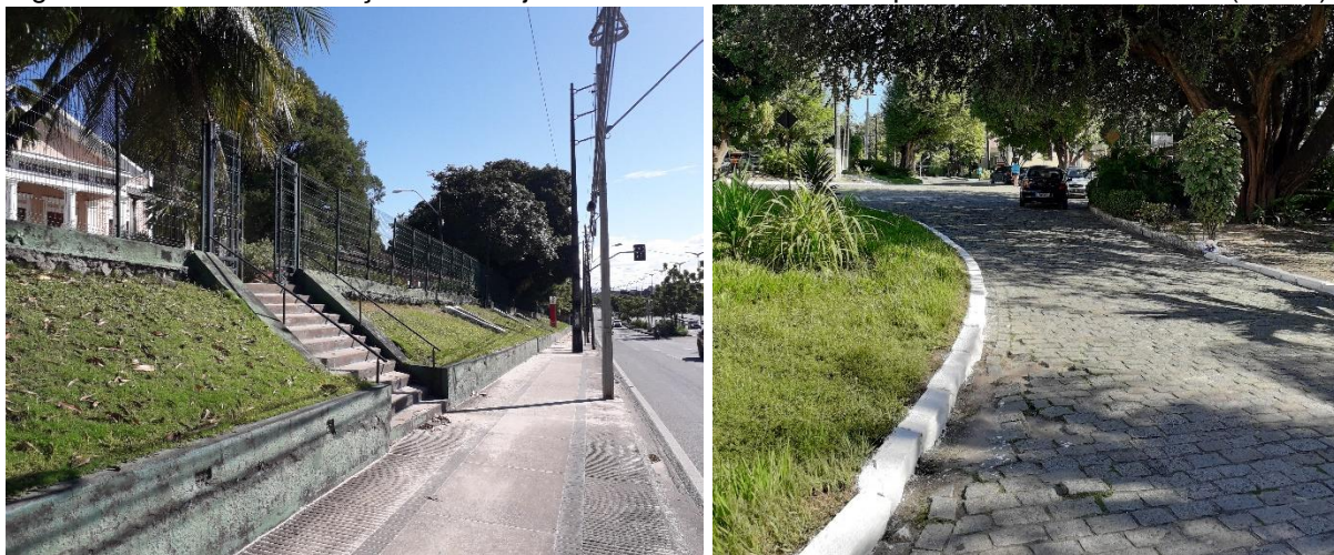
Figura 51 - Trecho sem calçadas no trajeto da Av. Mister Hull até a parada do ônibus interno (direita).
