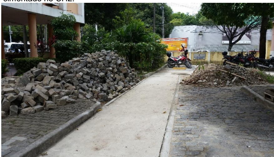
Figura 36 - Substituição de paralelepípedos por calçada em piso cimentado no CH2.
