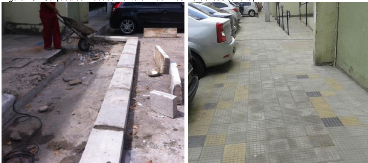
Figura 22 - Alargamento de calçada Bloco de Fisiologia / Farmacologia (esquerda). Figura 23 - Calçada com acabamento em ladrilhos hidráulicos (direita).
