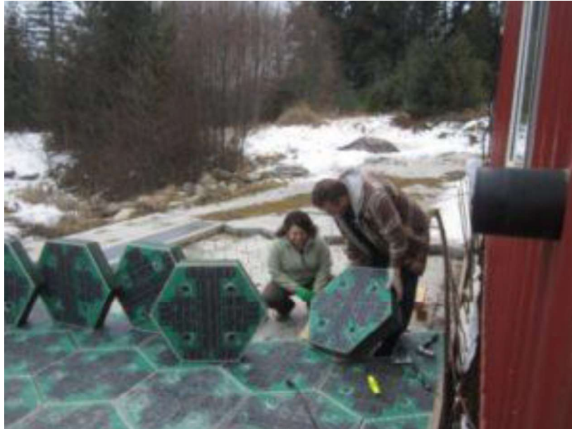
Figuras 5 – Instalação das placas do sistema Solar Roadway
