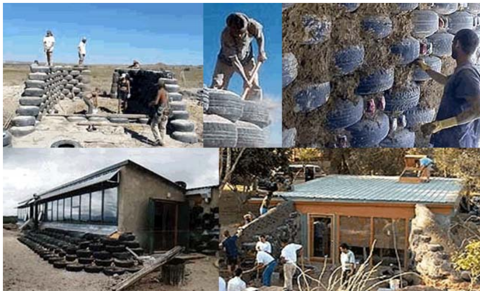
Figura 2.6: Construção de Edificações com Pneus (ODA, 2003)
