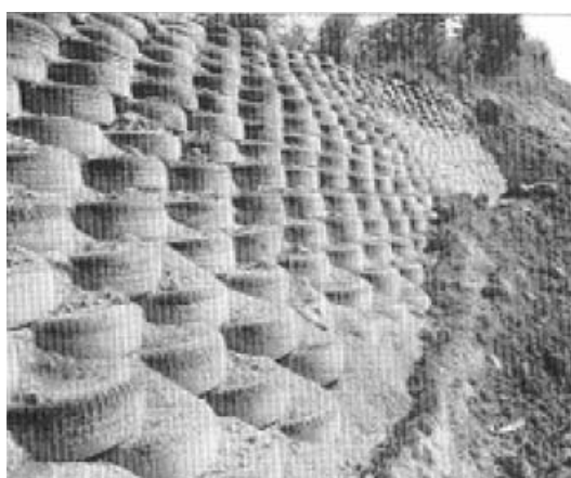
Figura 2.7: Muro de Pneus na Contenção de Encostas (SILVA, 2004)
