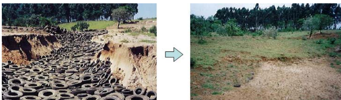
Figura 2.8: Utilização de Pneus na Recuperação de Erosões (CAPPI, 2004)
