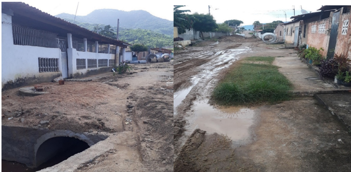
Figura 39 - Obras de microdrenagem no bairro Novo Maranguape I
