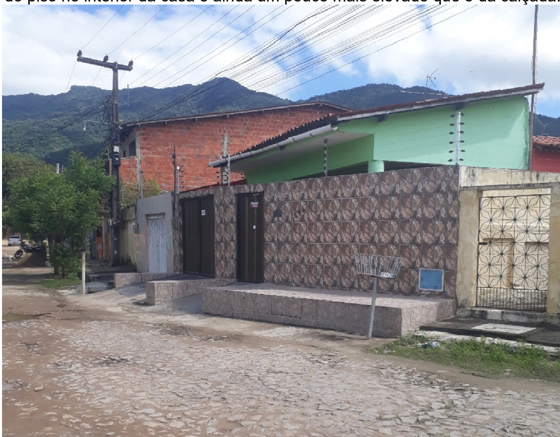
Figura 42: Uma das casas, no bairro Preguiça, cujo nível do piso foi elevado. O nível do piso no interior da casa é ainda um pouco mais elevado que o da calçada.
