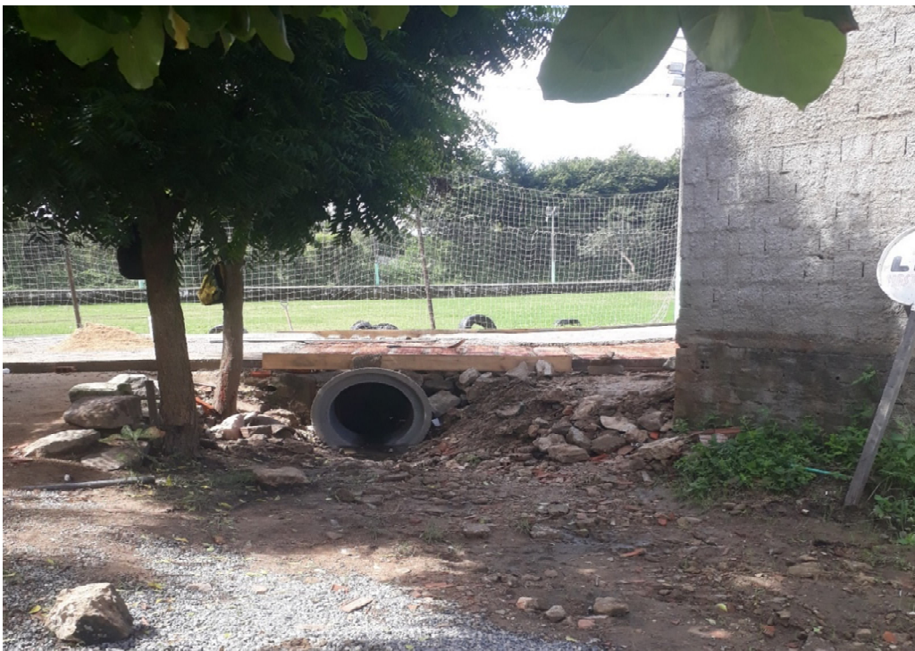
Figura 38 - Bueiro localizado no bairro Preguiça
