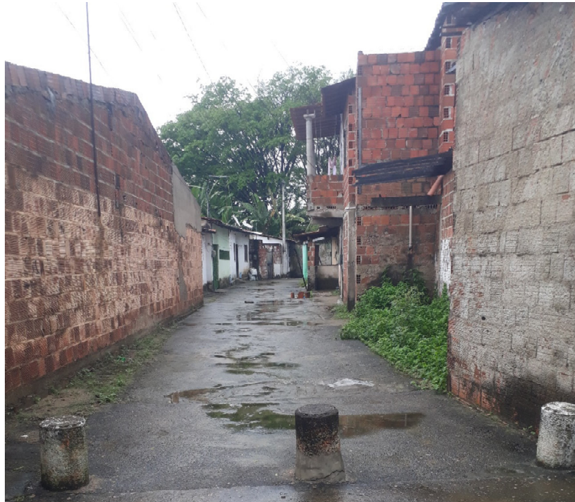
Figura 31 - Canalização de um riacho no bairro Parque Santa Fé
