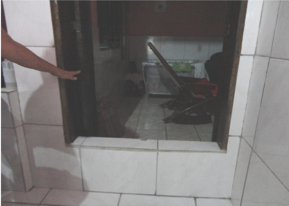
Figura 20 – Moradora do bairro Preguiça indicando o nível alcançado pela água durante inundação ocorrida em 30 de março de 2009.
