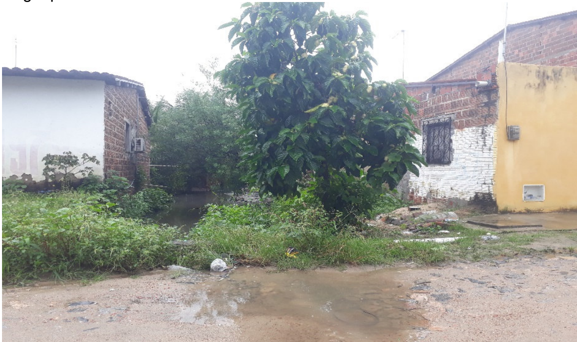
Figura 27 - Presença de casas às margens de um riacho no bairro Santos Dumont, Maranguape
