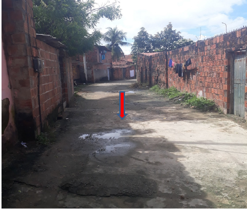
Figura 30 - Canalização de trecho de um dos tributários do rio Pirapora, no bairro Preguiça, Maranguape (CE)
