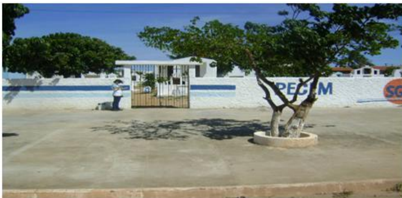
Foto 29. Cemitério de Pecém ao longo da CE 346 - Pecém – Taíba (Novembro/2010). UTM – 517988/9607142.
