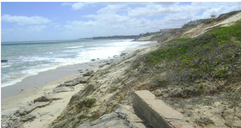
Foto 14. Extremidade do muro de proteção na praia do Pacheco – Caucaia (Novembro/2010). UTM – 539989/9592442.
