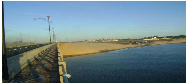
Foto 11. Paisagem parcial da recém construída ponte na foz do rio Cocó (Outubro/2010). UTM – 562546/9582660.
