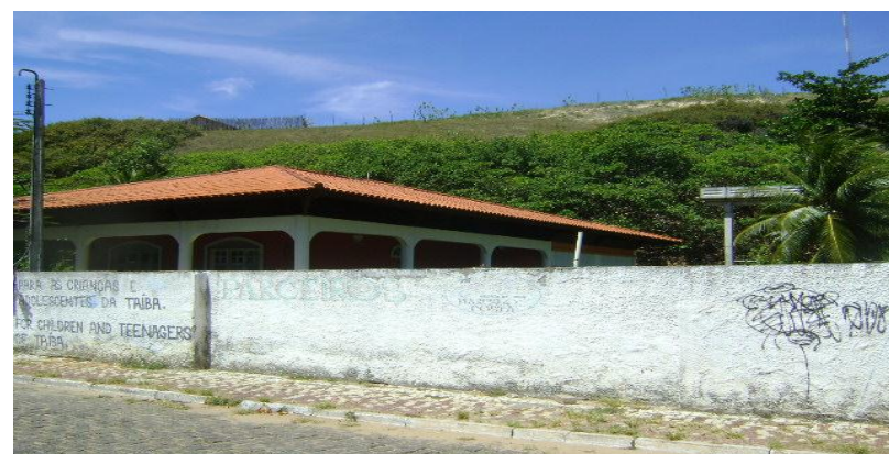
Foto 24. Uso e ocupação do solo na Praia da Taíba, onde predominam residências de veraneio (Novembro/2010).
