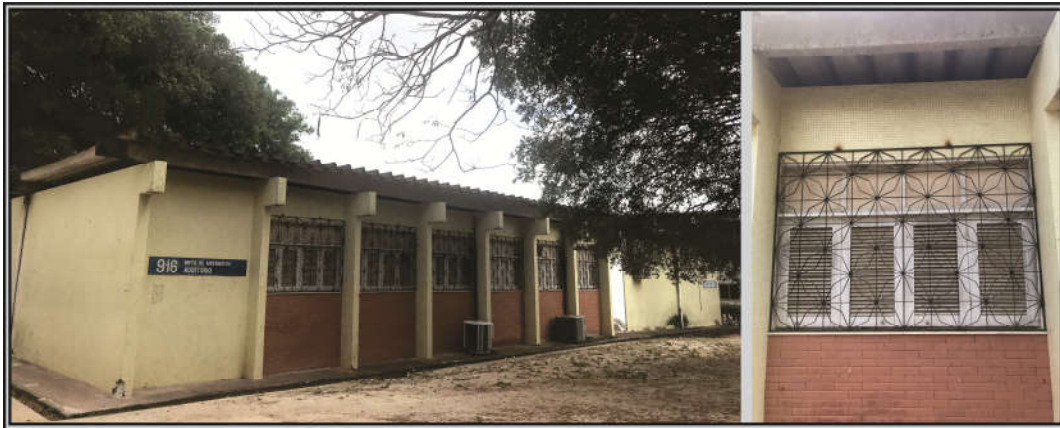
Fig. 101. Esquadrias de madeira – Bloco 916 – Tipologia SA-2 – Centro de Ciências – Campus do Píci (2018)
