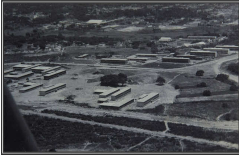
Fig. 81. Vista aérea Campus do Pici (1970) Nota-se diferença na implantação dos blocos por Centros.
