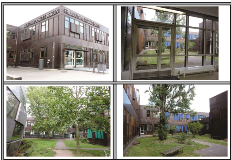
Fig. 25. Fachadas em aço corten da Universidade Livre de Berlim
