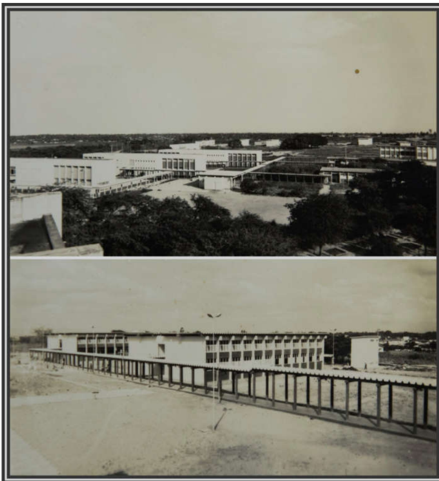
Fig. 86. Passarelas conectando os edifícios – Campus do Pici
