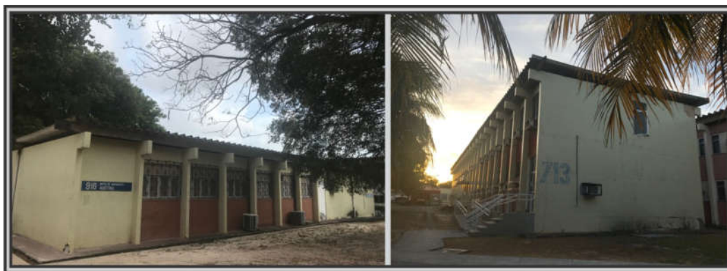
Fig. 100. Edifícios do Campus do Pici - marcação da estrutura Bloco 916 (Centro de Ciências) e Bloco 713 (Centro de Tecnologia)
