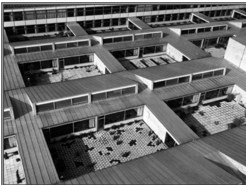
Fig. 13. Foto aérea dos pátios da Escola Munkegards
