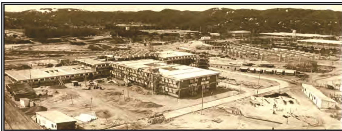
Fig. 61. Obras de construção do campus universitário UFRN
