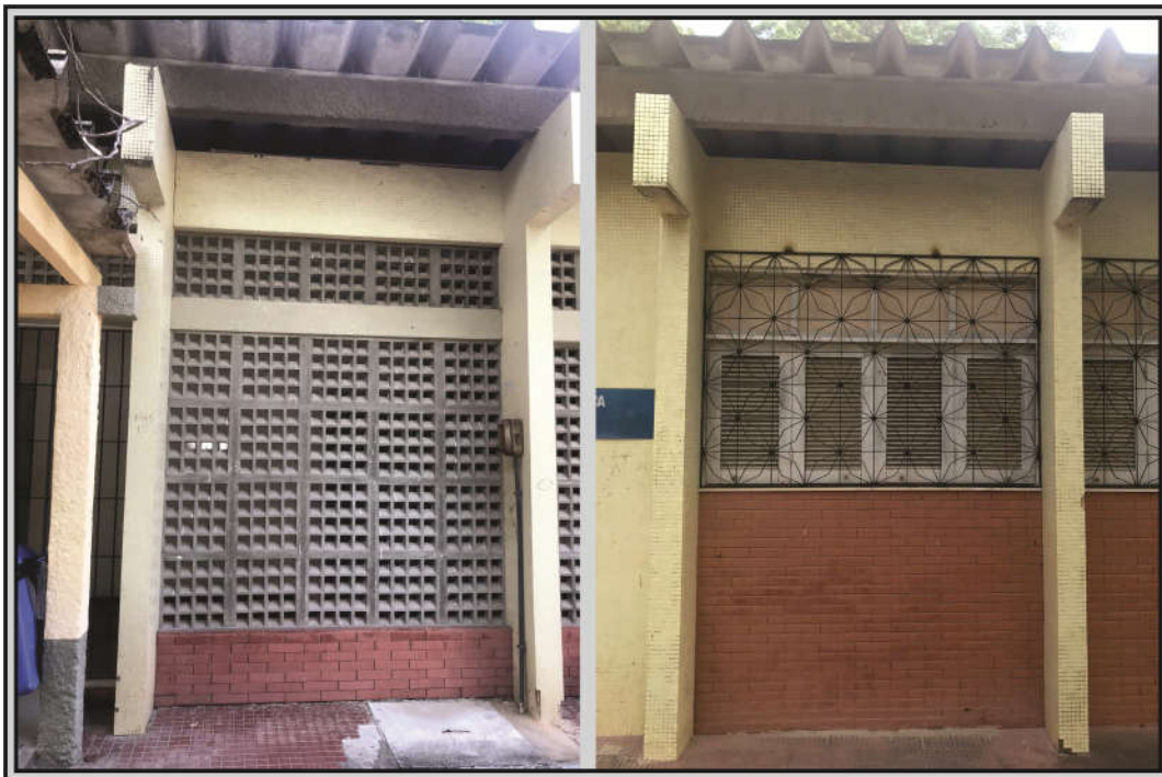
Fig. 102. Cobogós e esquadrias instalados entre os pilares seguindo a modulação - Campus do Píci (2018)
