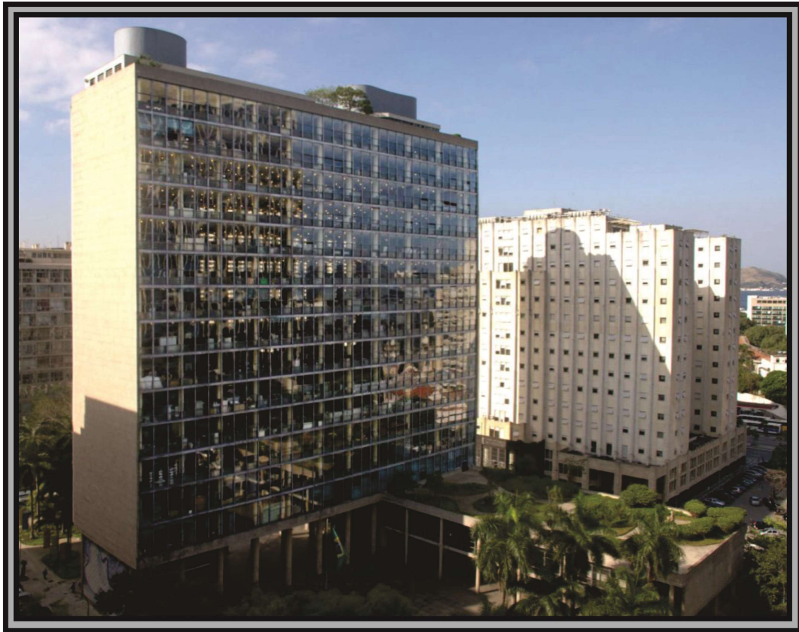
Fig. 2. Edifício Ministério da Educação e Saúde, Rio de Janeiro
