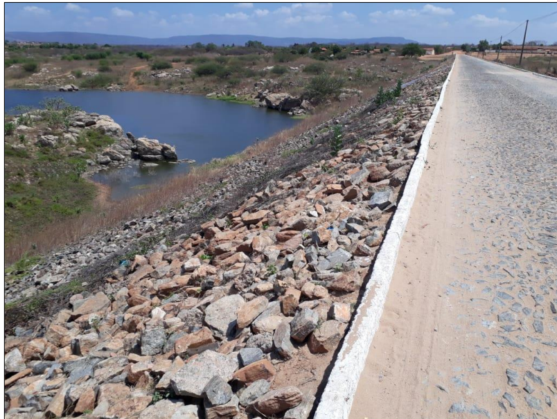
Figura 7 – Talude de montante da barragem do Realejo, Crateús-CE
